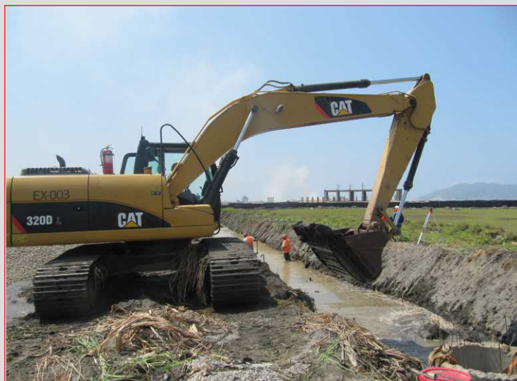
Obras mejoraran calidad de vida de población
