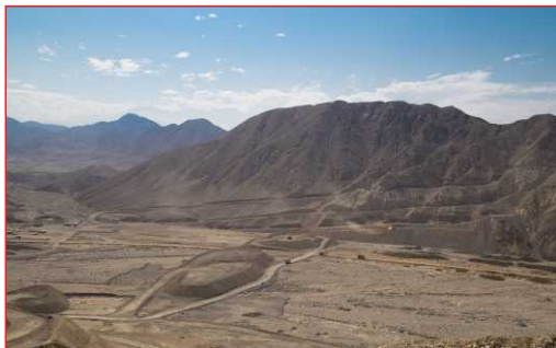
Vista panorámica de zona donde se construye Presa Palo Redondo
