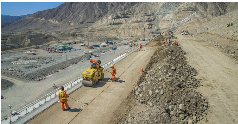
Proceso constructivo de Presa Palo Redondo - III Etapa
