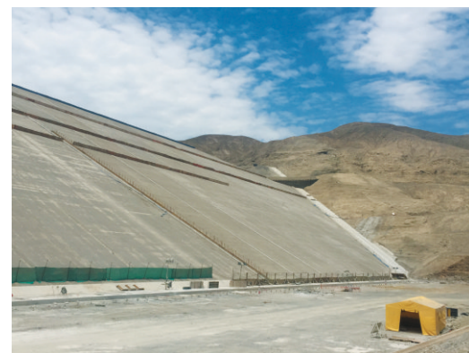
Construcción de Presa Palo Redondo - III Etapa CHAVIMOCHIC
