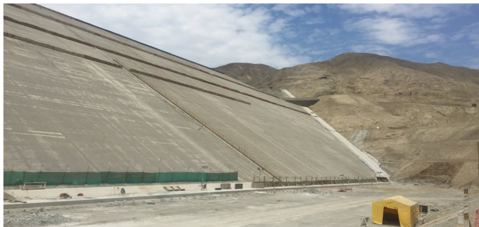
Construcción de Presa "Palo Redondo" - valle de Chao
