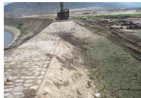
Trabajos de enrocado de diques
