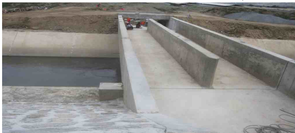
Construcción de canoas de concreto para protección de canal madre
