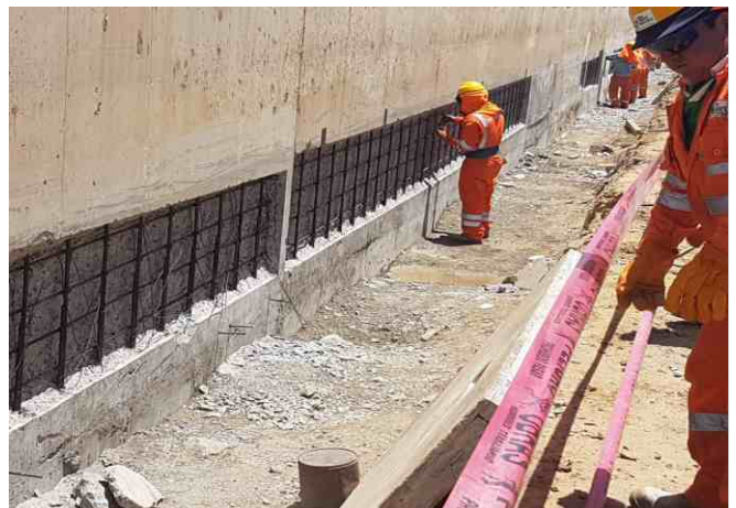
Trabajos de mantenimiento de Canal Madre a cargo de Sub Gerencia de Operación y Mantenimiento
