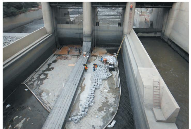
Colocación de piedra labrada en piso de barraje móvil de Bocatoma Chavimochic
