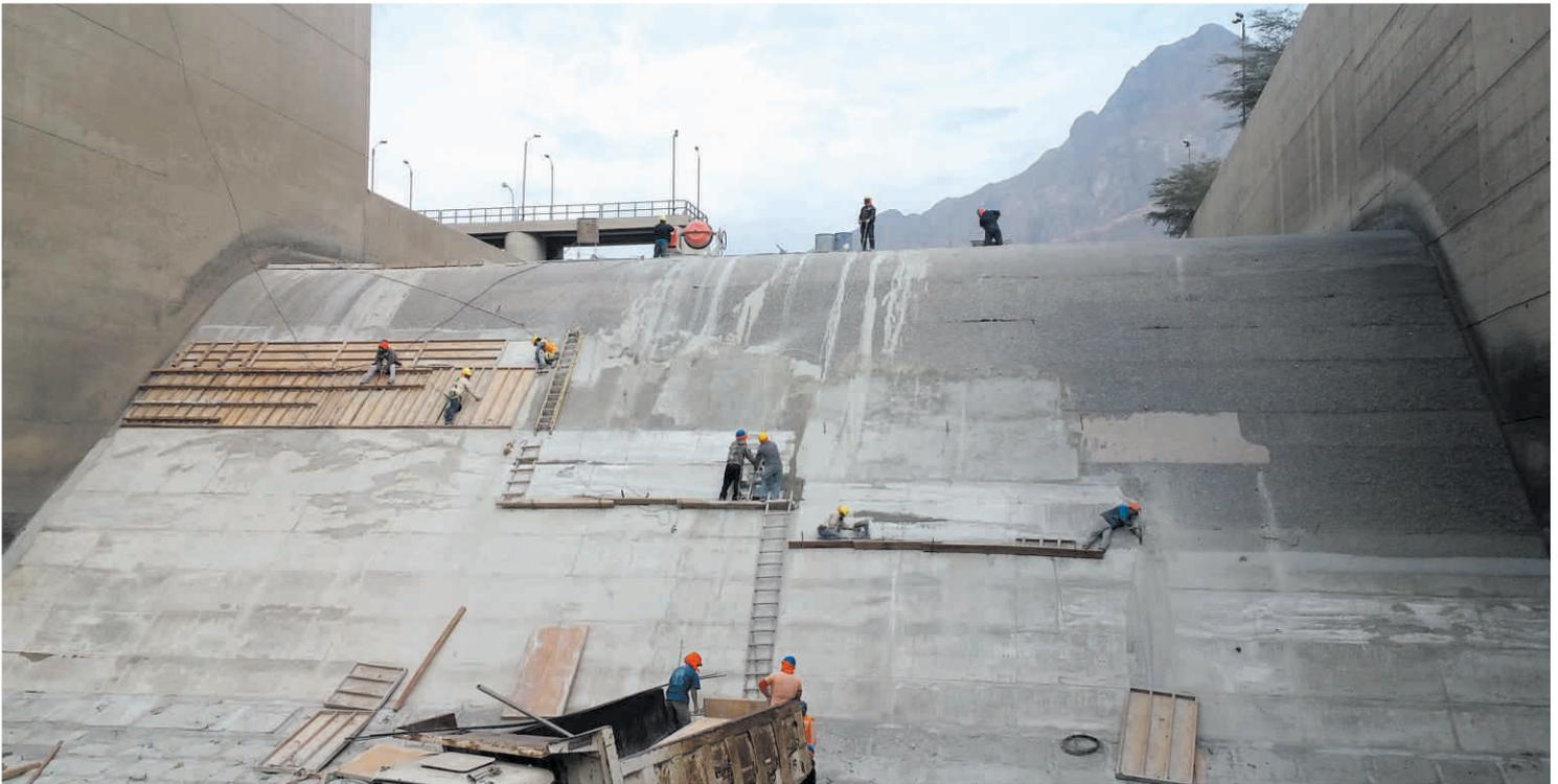
Personal realiza labores de revestimiento y subsanación de barraje fijo de Bocatoma CHAVIMOCHIC
