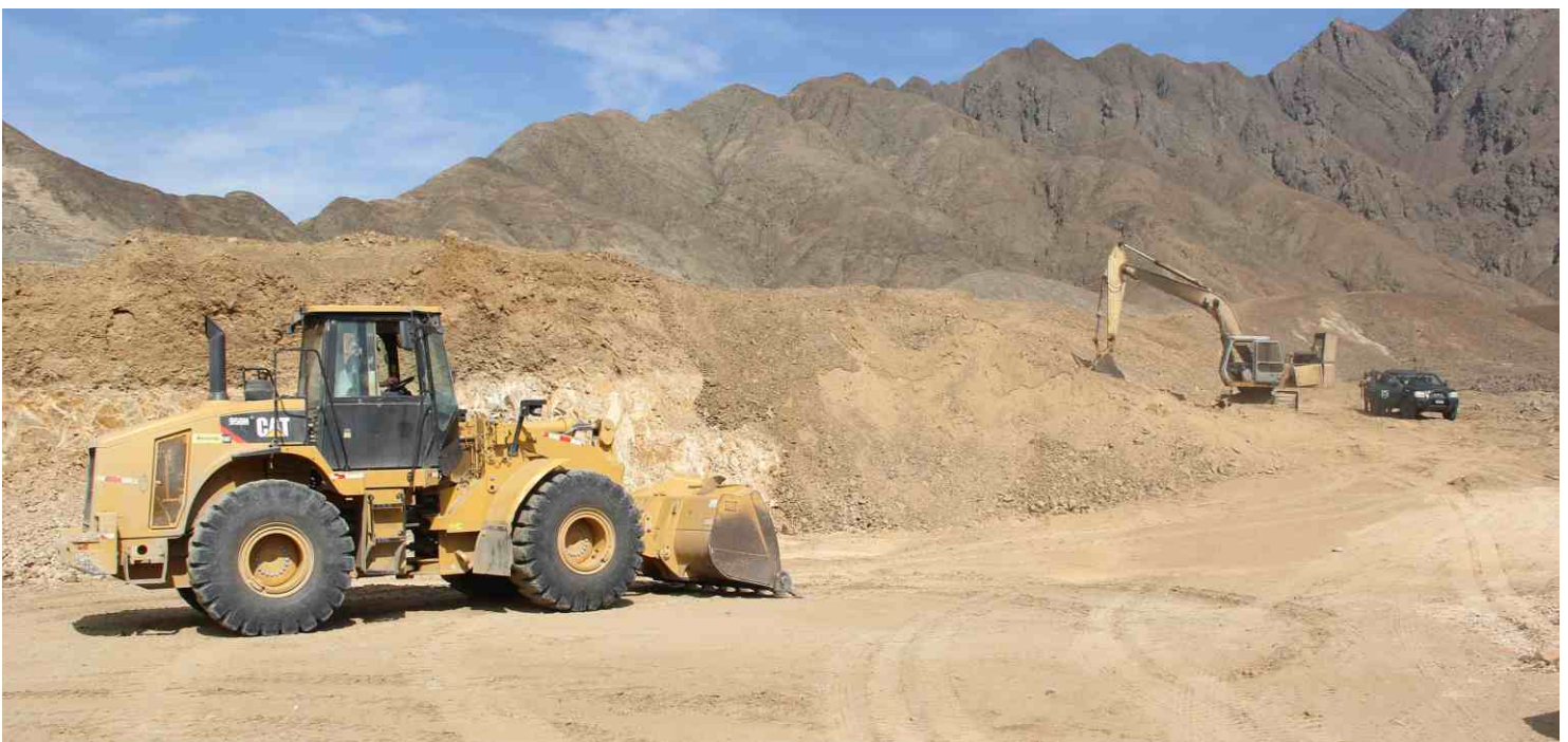
Construcción de camino a Zaraqúe - Vinzos - Susanga, beneficiará a más de mil habitantes en la provincia de Virú
