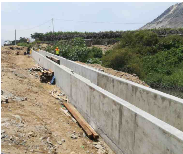
Reparación de canal evacuador de la Planta de Tratamiento de Agua Potable de Trujillo PTAP, afectada por Niño Costero 2017
