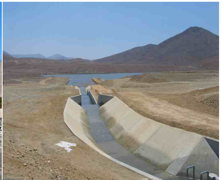
Chavimochic no captará agua para dar mantenimiento a la rápida RA-3 en Palo Redondo
