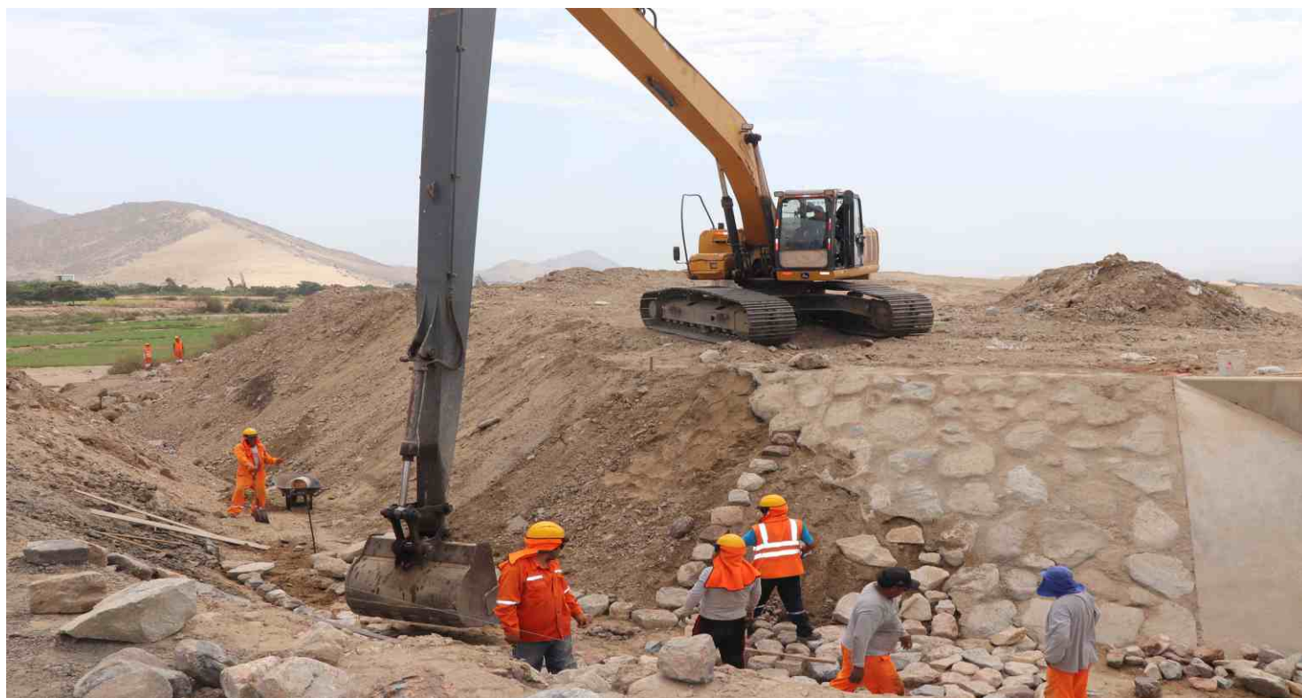
Gerente del PECH, Abog. Carlos Matos Izquierdo, inspecciona trabajos de protección de canal madre Chavimochic
