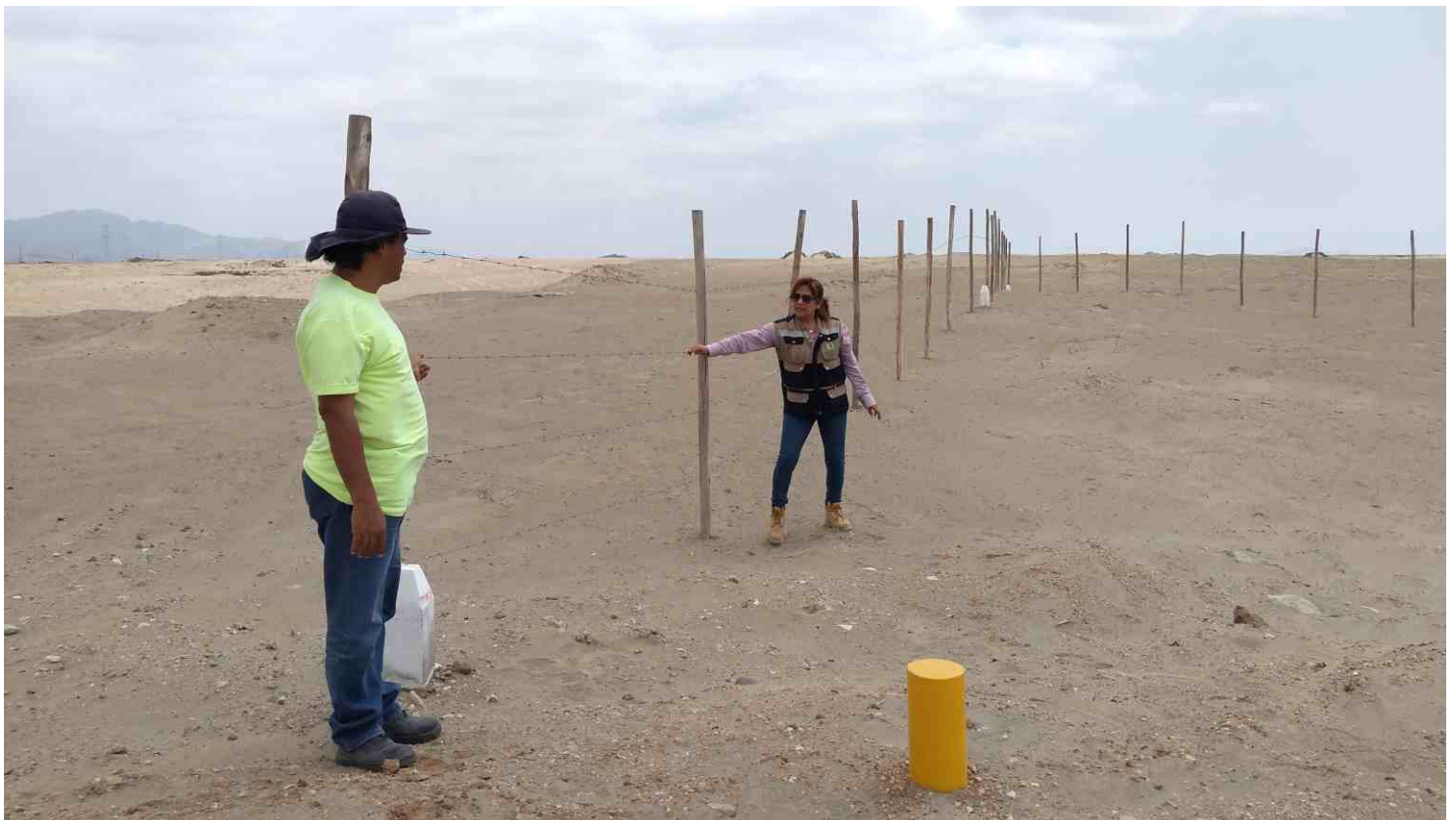
Instalación de cerco de alambres y postes de madera en trazo del canal madre - valle Chicama
