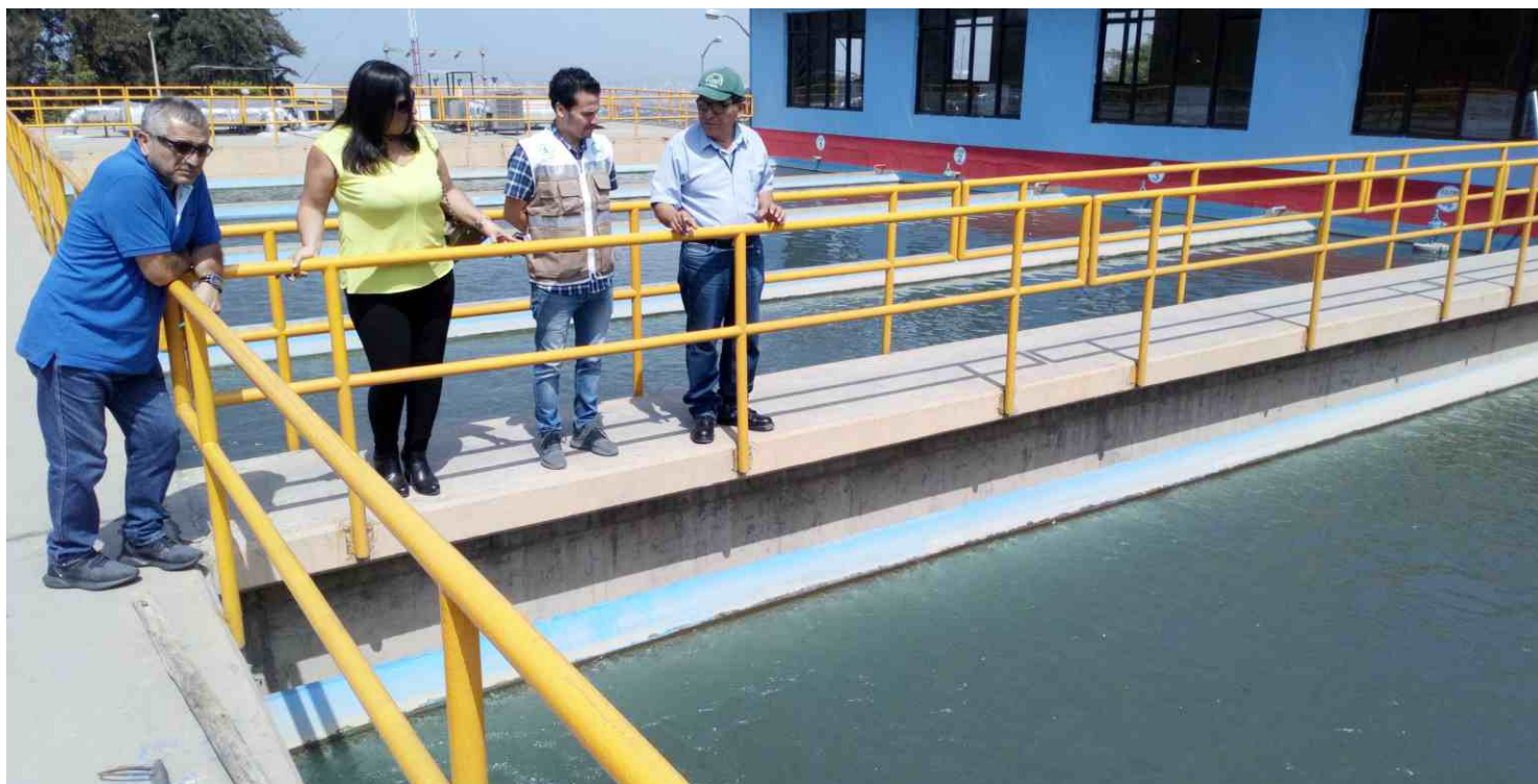
Administrador y funcionarios del PECH supervisan calidad de agua potabilizada por la PTAP
