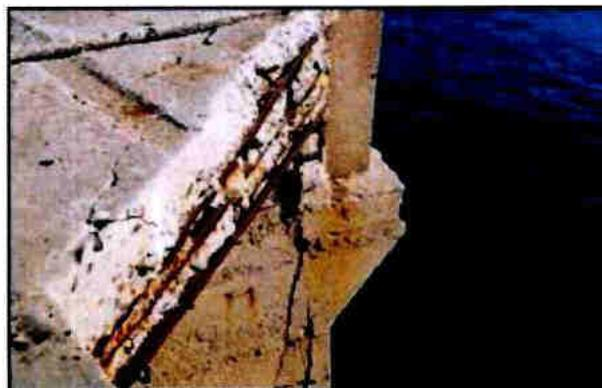
Alternativas de solución: Uso de lechada con aditivos como la resina epóxica o solamente lechada de cemento para el recubrimiento de las armaduras expuestas al aire; se
