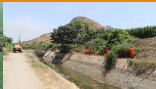
LIMPIEZA DE DRENES
