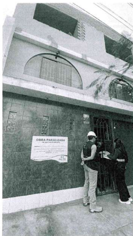
Figura 5. Supervisión ambiental en materia de ruido en obra de construcción. Fuente: Elaboración propia.
