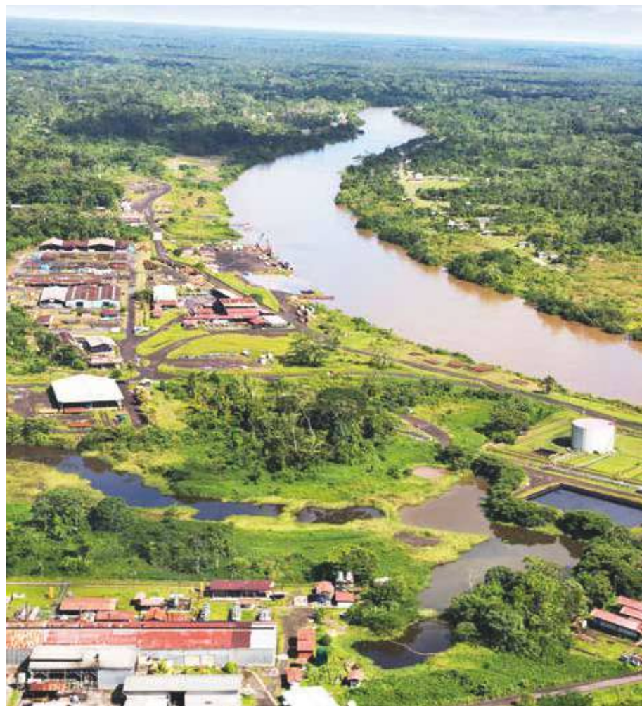
Planta y Villa Trompeteros, Lote 8. Foto GFHL-Osinergmin.
