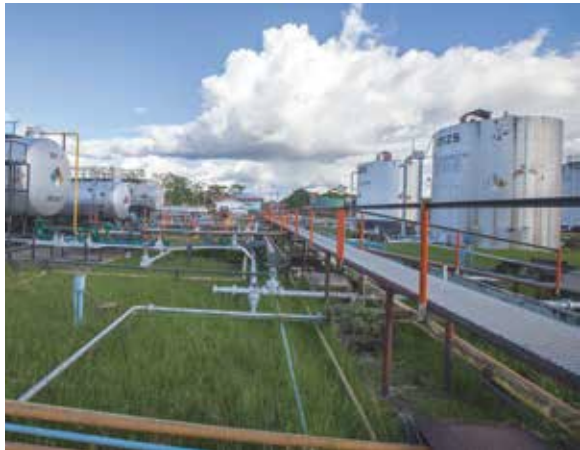
Planta Lote 8. Foto GFHL-Osinergmin.
