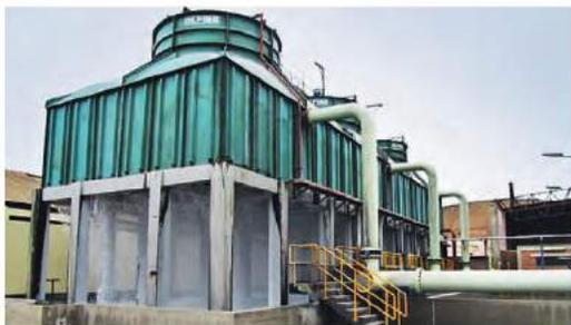
Foto: Biomasa Paramonga, radiadores del sistema de refrigeración de TV1-Perú. Fuente: DSE-Osingermin.
