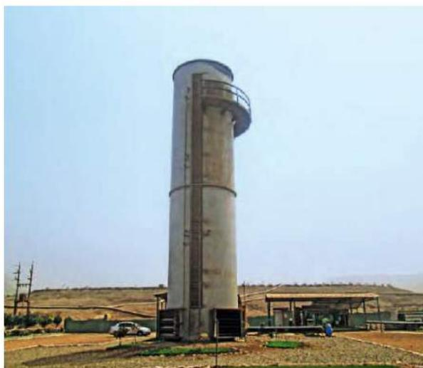
Foto: La Gringa V, Perú. Estación de quemado de excedentes de biogás. Fuente: Osinergmín.
