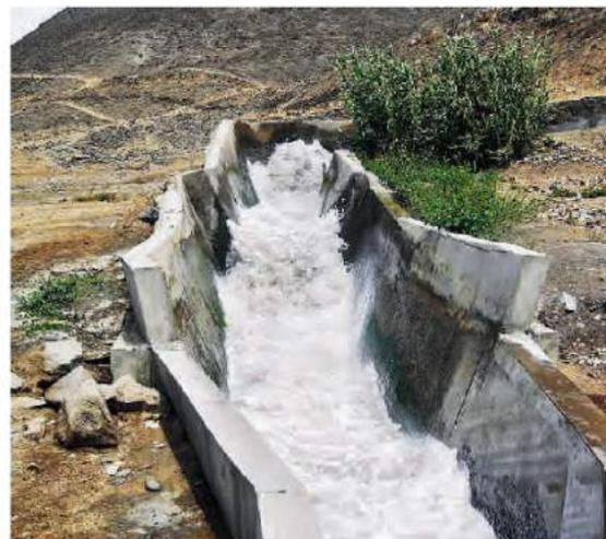
Foto: Mini hidráulica Purmacaná Perú, canal de conducción. Fuente: Osnergrin.
