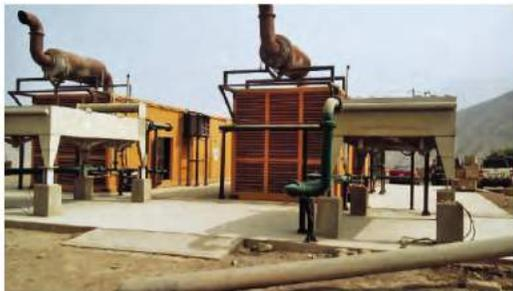
Foto: Biomasa La Gringa, Sistema de enfriamiento de motores-Perú. Fuente: DSE-Osingermin.
