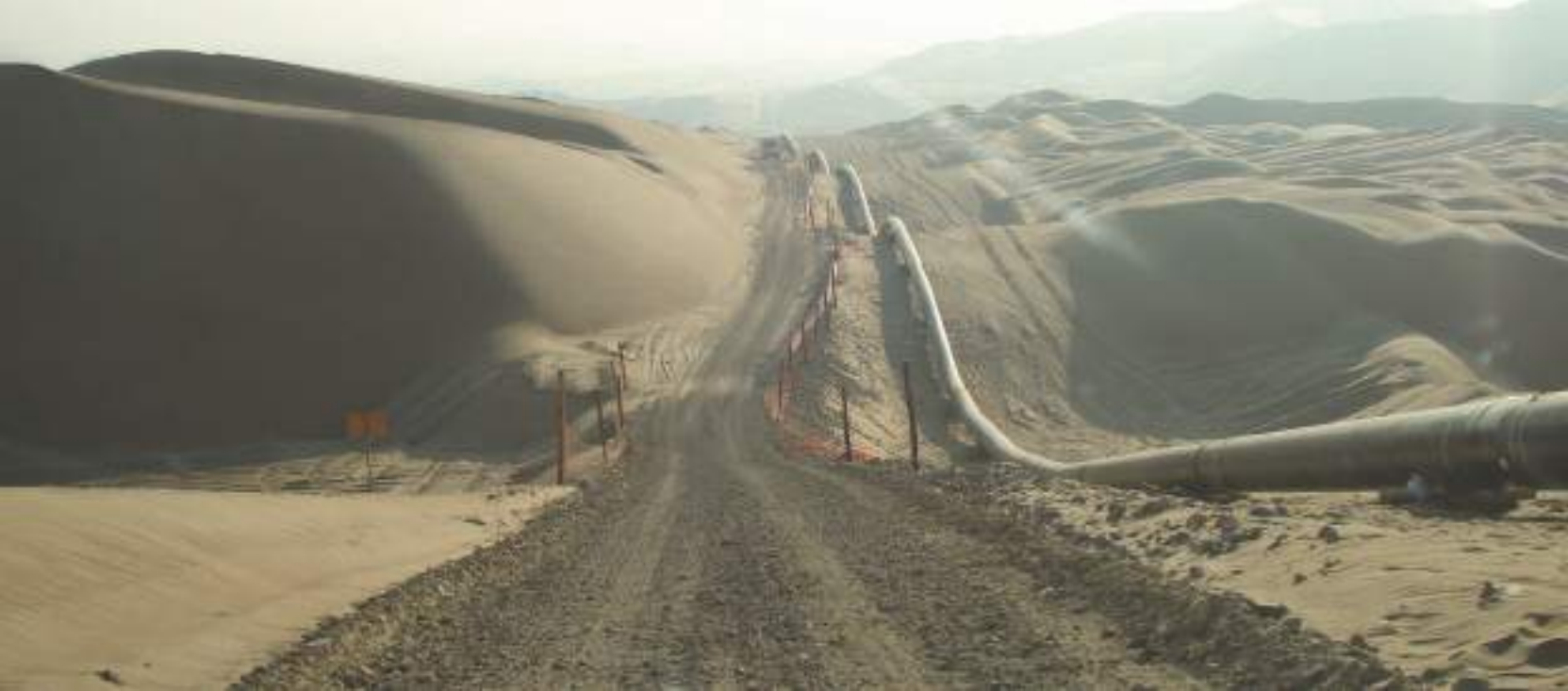
Foto: Tendido del gasoducto a cargo de TGP, Perú.
