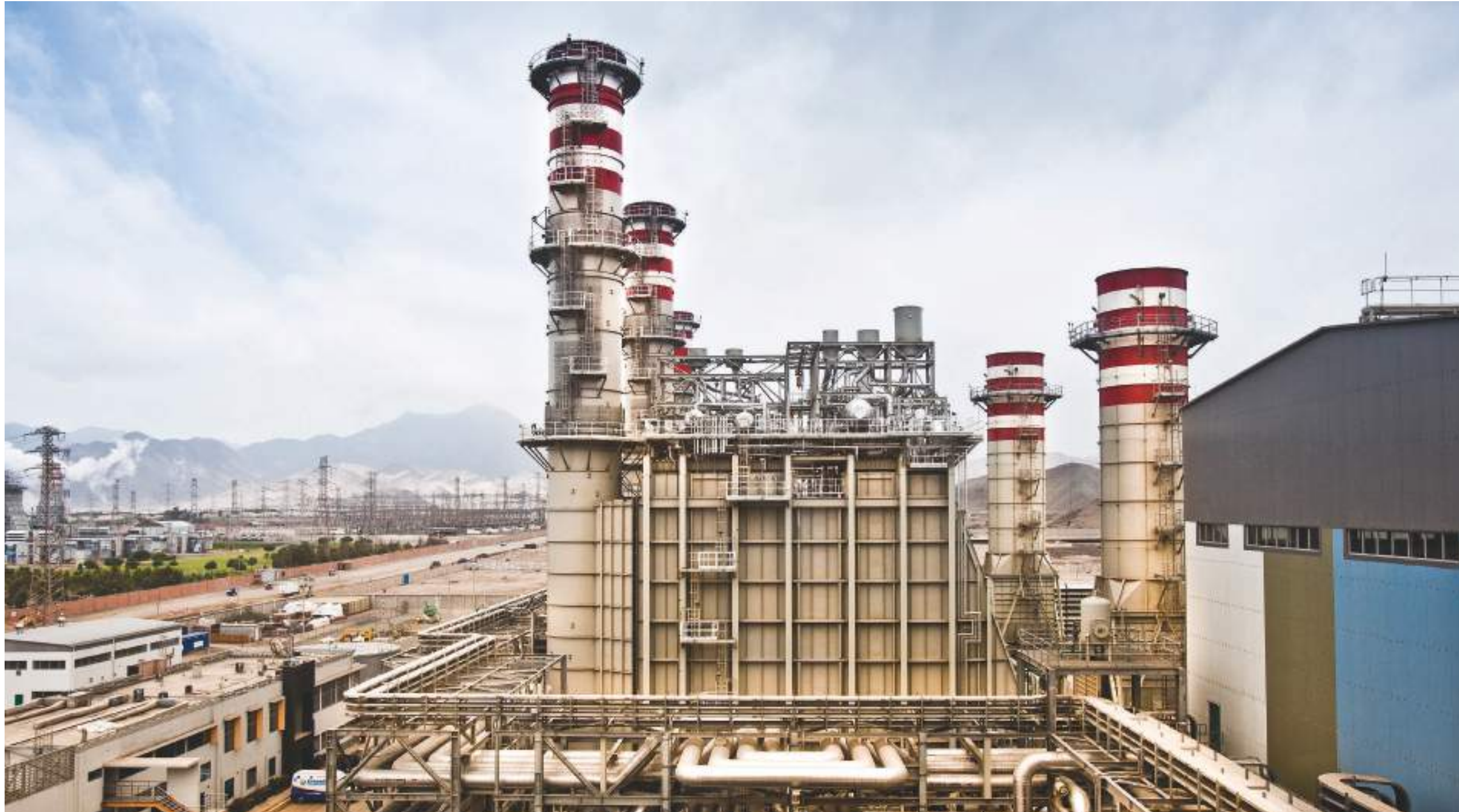
Foto: Planta termoeléctrica Chilca, Lima-Perú.
