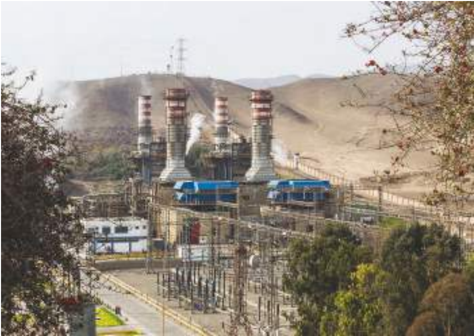
Foto: Central termoeléctrica de Ventanilla, Lima-Perú.
