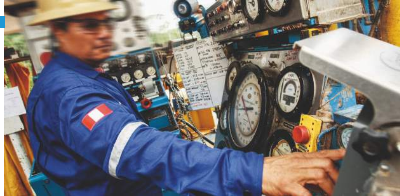
Foto: Instalaciones de la planta de separación de gas Malvinas, Cusco-Perú.
