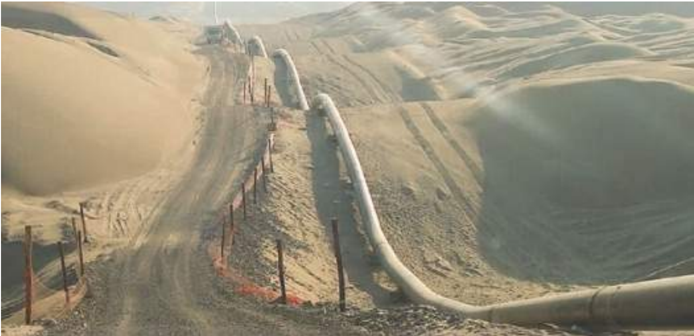
Foto: Tendido del gasoducto a cargo de TGP, Perú.
