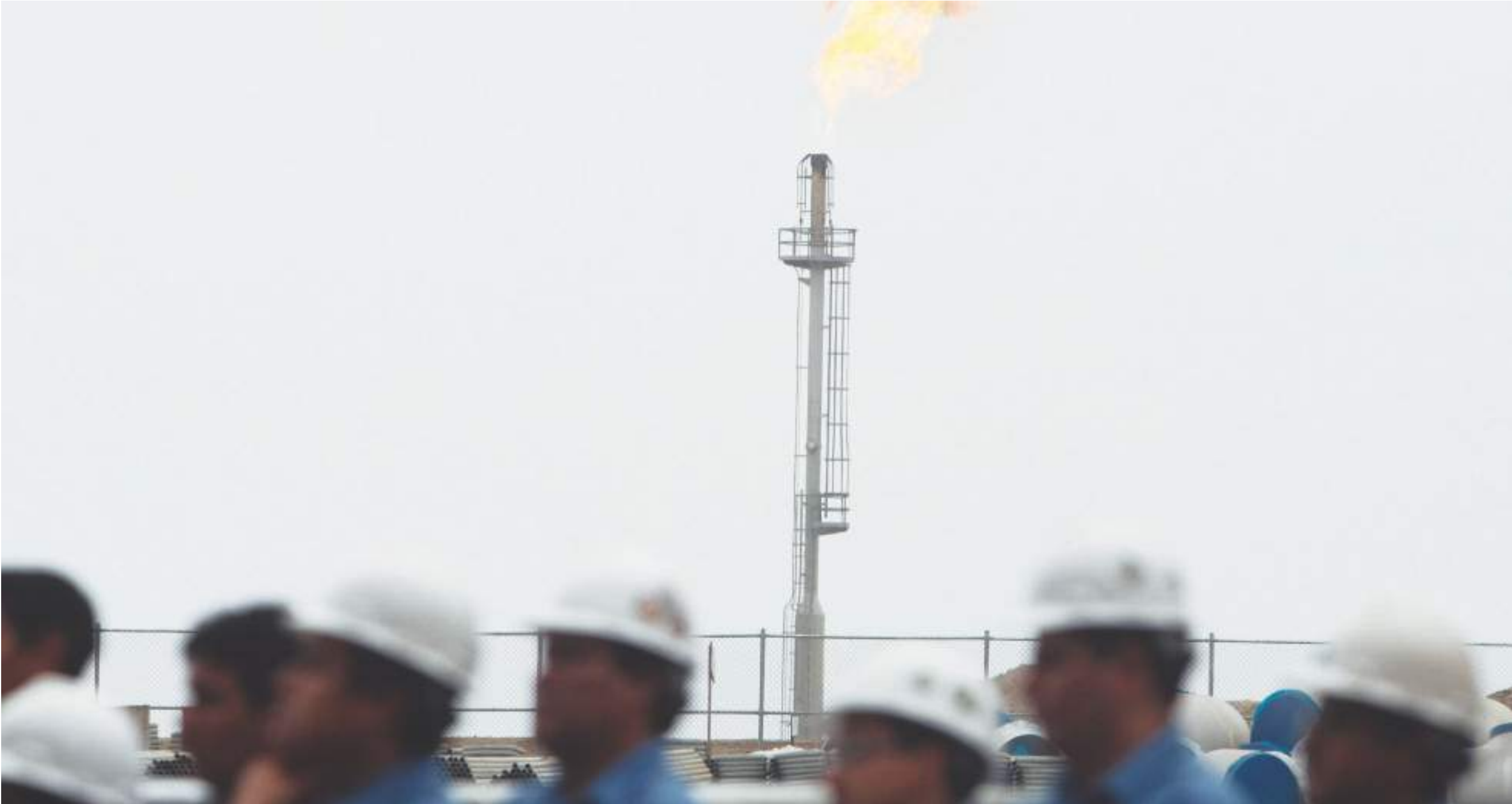
Foto: Inauguración de la planta de licuefacción de gas natural Pampa Melchorita, Lima-Perú.
