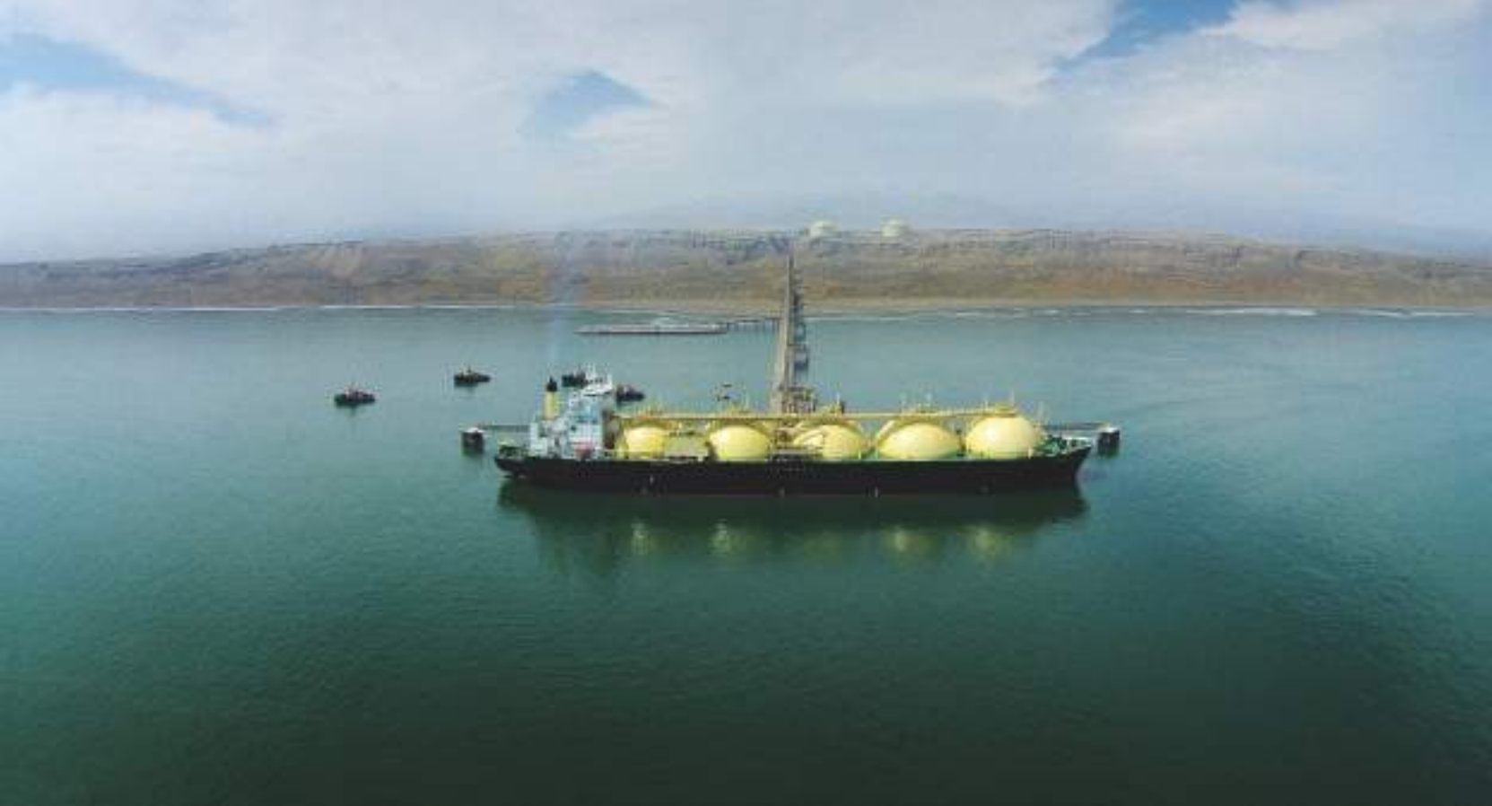
Foto: Buque metanero (buque tanque de GNL) en las instalaciones marítimas de Melchorita, Lima-Perú.
