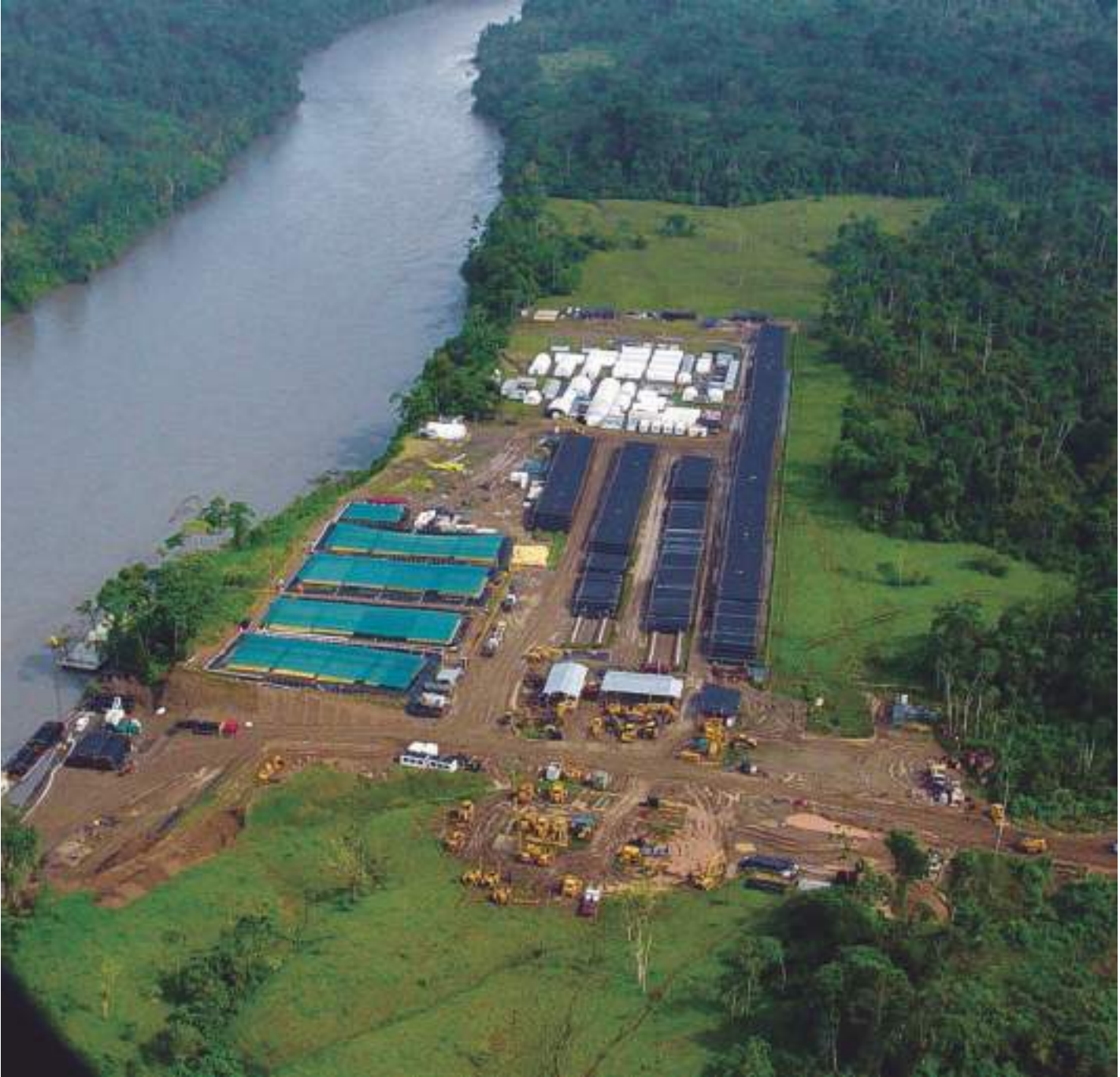
Foto: Construcción en Malvinas, Cusco-Perú.
