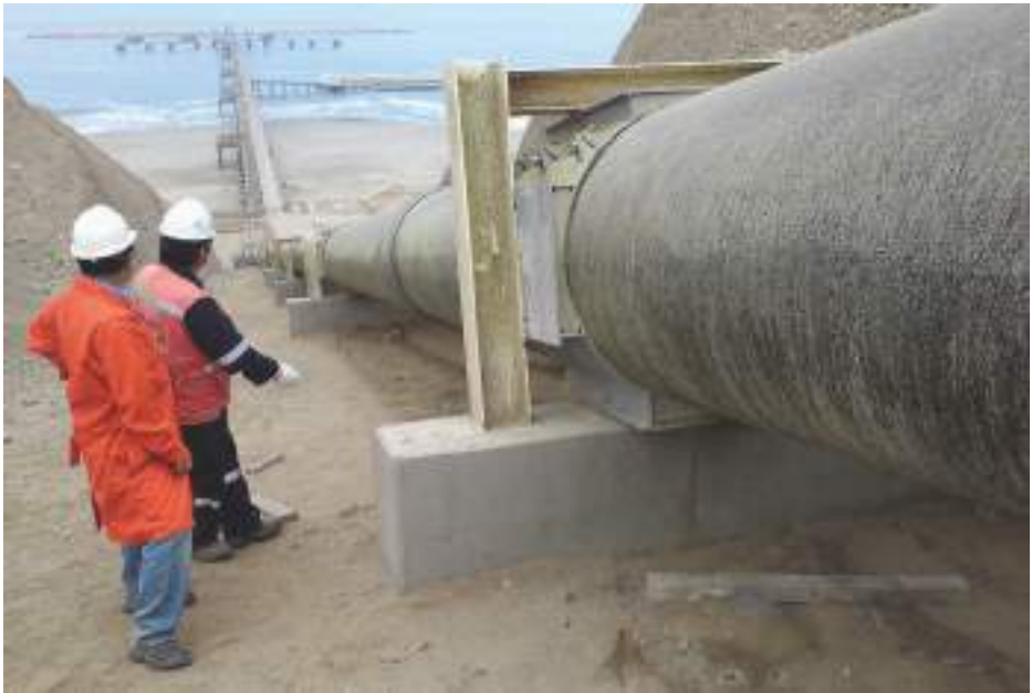
Foto: Tendido del ducto a las instalaciones marítimas de Melchorita, Lima-Perú.
