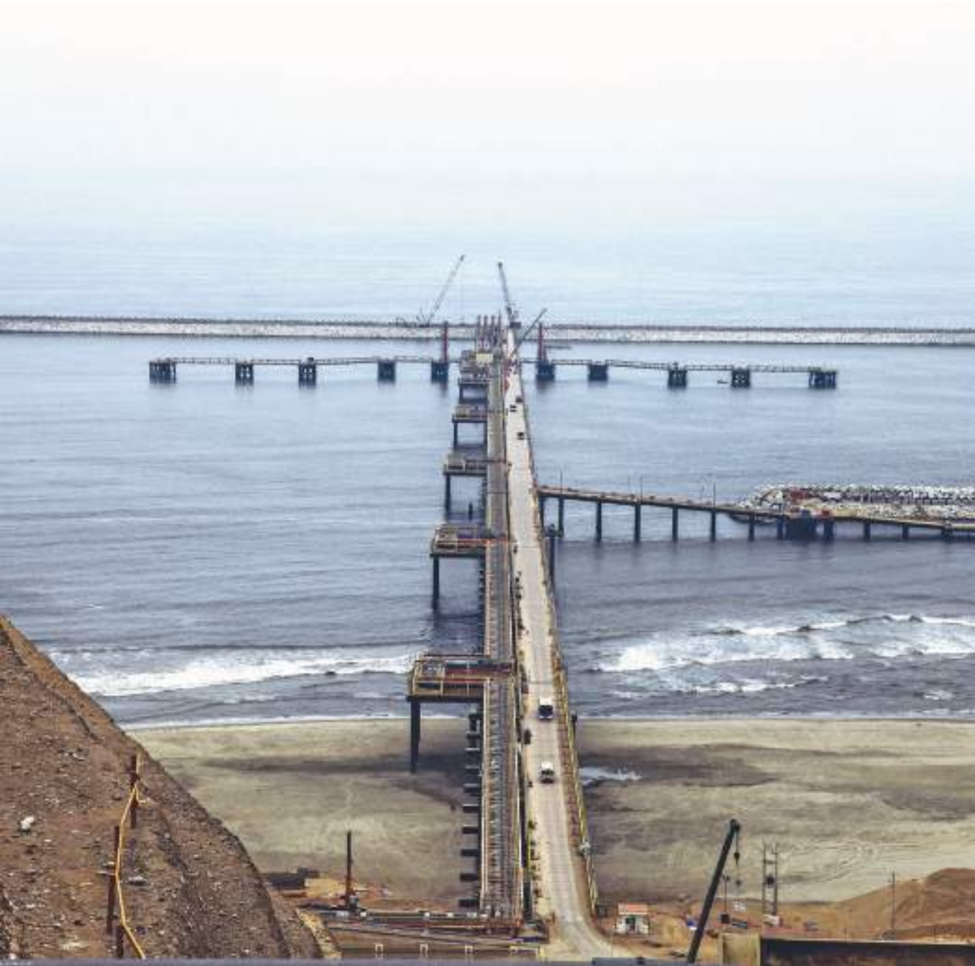
Foto: Instalaciones marítimas de GNL en Melchorita, Lima-Perú.
