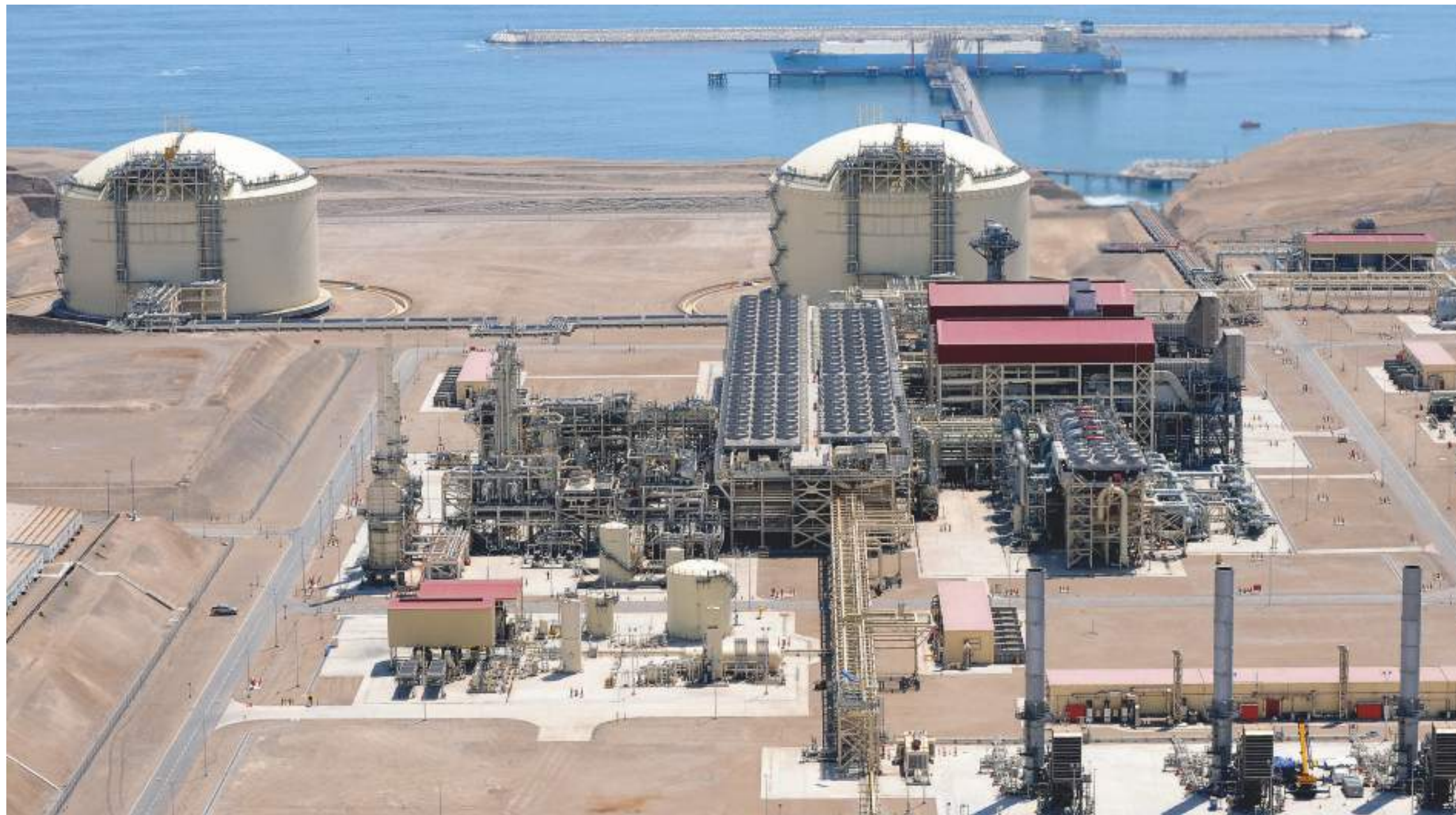
Foto: Vista panorámica de la planta de licuefacción de gas natural en Pampa Melchorita, Lima-Perú.
