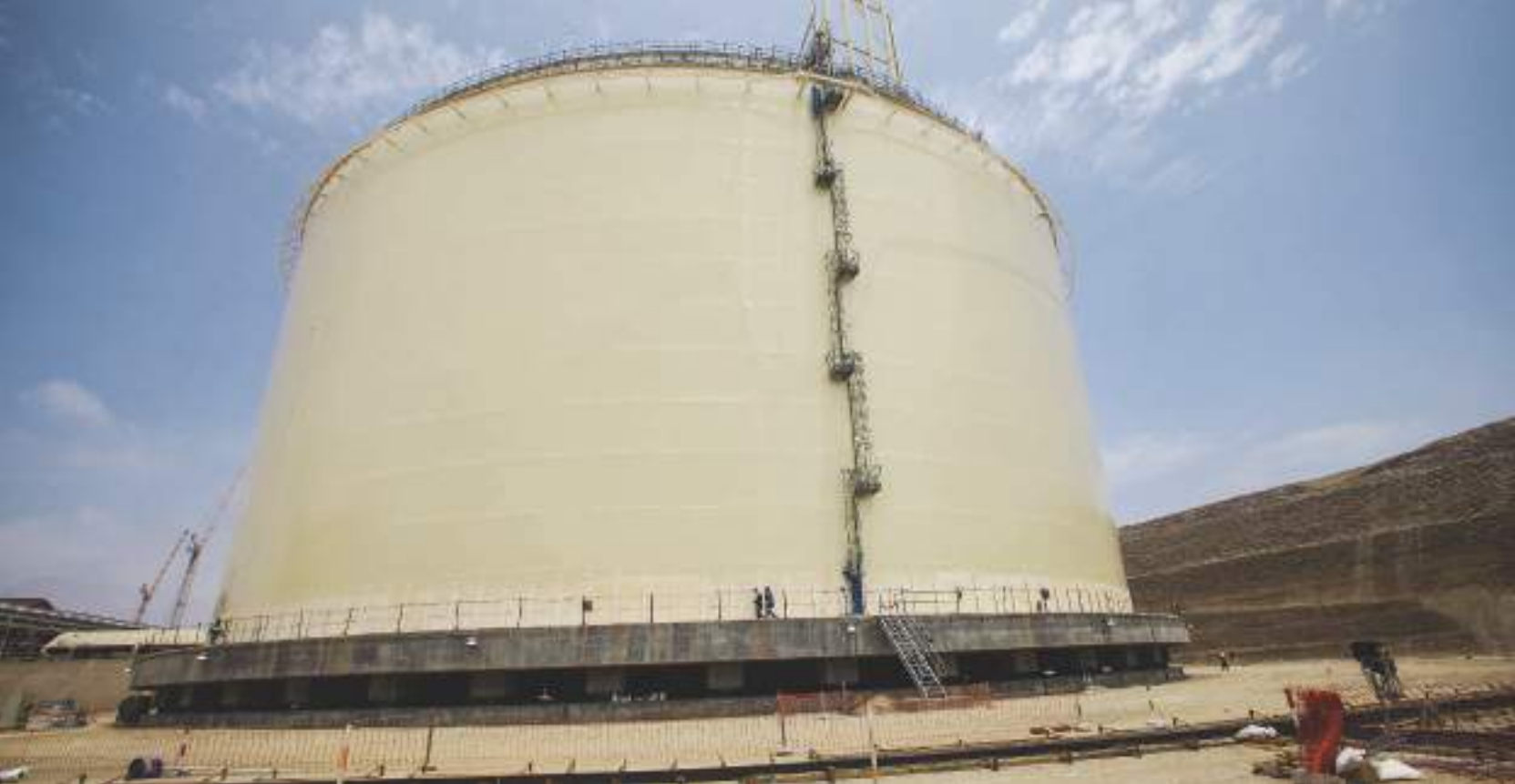
Foto: Planta de liquefacción de gas natural, Pampa Melchorita, Lima-Perú.
