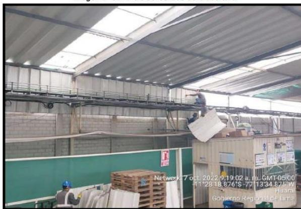
Se inicio la instalación y sellado con el material de plancha metálica TR4, con la finalidad de eliminar las emisiones de ruido a las poblaciones colindantes de la empresa.
