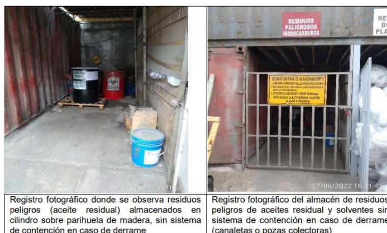
Fotografía 2: registro fotográfico del almacén de residuos peligrosos
