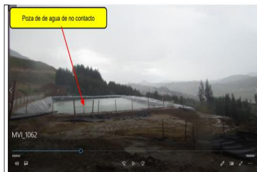
Video N° 10. Vista de la captura de video, donde se observa la poza de agua de no contacto que estaría colectando agua de escorrentía y el agua de contacto (agua de escorrentía en contacto con el material depositado en el DMI 2 sin recubrimiento) 248 .
