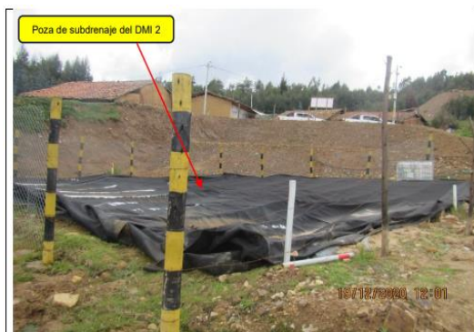
Fotografía 87. Vista de la poza de subdrenaje del DMI 2. Se observa que dicha poza se encontraba cubierta con geotextil en su totalidad y tiene unas medidas aproximadas de 10 x 10 metros 247 .
