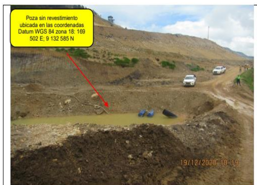
Fotografía 88. Vista de la poza sin revestimiento ubicada en una zona disturbada ubicada en las coordenadas Datum WGS 84 zona 18: 169 502 E; 9 132 585 N 251 .
