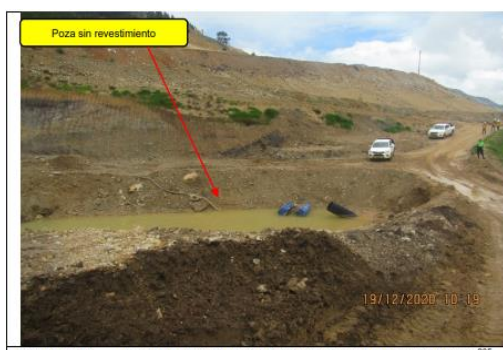
Fotografía 81. Vista de la poza sin revestimiento ubicada en una zona disturbada 255 .
