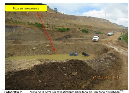
Fotografía 81. Vista de la poza sin revestimiento habilitada en una zona disturbada 245 .
