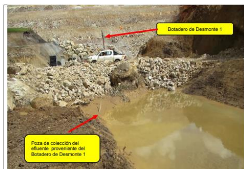
Fotografía 52. Donde se observa la poza sin revestimiento que colecta el efluente proveniente del Botadero de Desmonte 1 199 .
