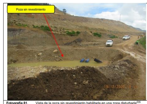
Fotografía 81. Vista de la poza sin revestimiento ubicada en una zona disturbada 250 .
