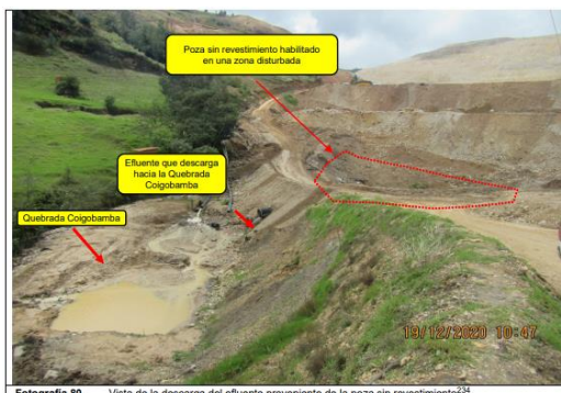
Fotografía 80. Vista de la descarga del efluente proveniente de la poza sin revestimiento 249 .
