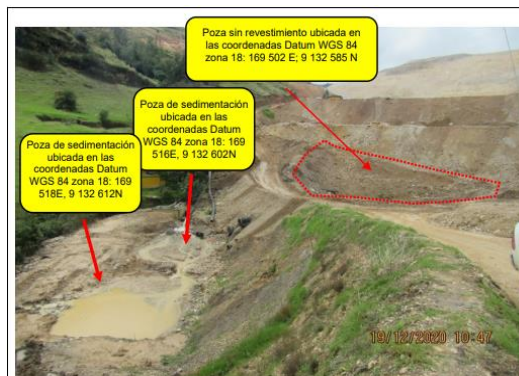
Fotografía 89. Vista de las pozas de sedimentación ubicadas en las coordenadas UTM WGS 84 zona 18: 169 516E, 9 132 602N, 169 518E, 9 132 612N 252 .
