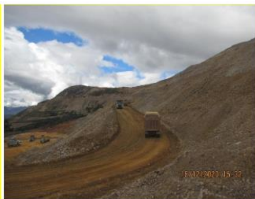
Fotografía 27. Otra vista de los camiones volquetes descargando el desmonte, las tolvas no se encuentran cubiertas con mantas 167 .
