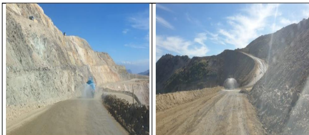
Fotografía 99. Vista del riego en la vías de acarreo (año 2020)
