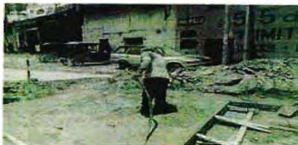
Figura 3 Armado de porrilla de acero
