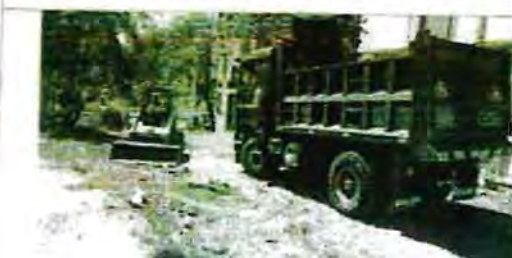
Figura N°10: TRABAJOS SINTIENDO DE EJECUCIÓN DE ACTIVIDAD.
