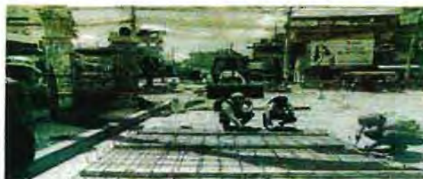
Figura 3 Armado de porrilla de acero
