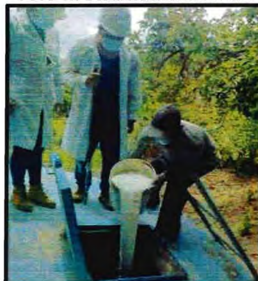
FOTO 10: Desinfección del reservorio.
