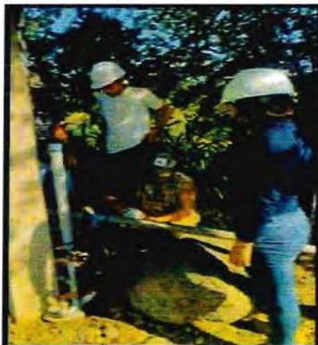
FOTO 35: Instalación de la bomba de ariete.
