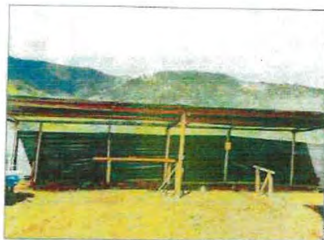
Figura 57. Construcción del Taller de distribución de alimentos y alimentación
