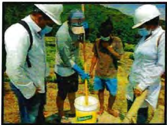
FOTO 07: Disolución del Hipoclorito de Calcio
