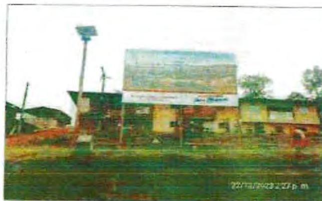
Figura 58. Construcción del local de alimentación de la escuela N° 1001
