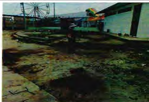
Foto 10: Apoyo con Limpieza/Chaleo en el Campo Ferial Linderos
