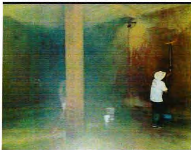
FOTO 17: Limpieza del reservorio de la Fila Alta
