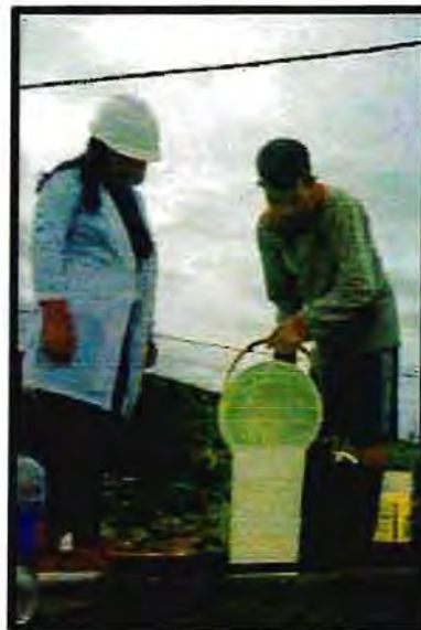
FOTO 13: Desinfección del reservorio.
