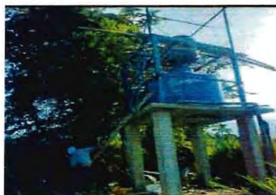
FOTO 33: Instalación de tanques y tubería.
