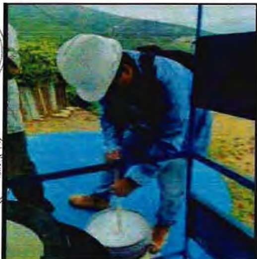
FOTO 21: Calibración del gotero del sistema de cloración
