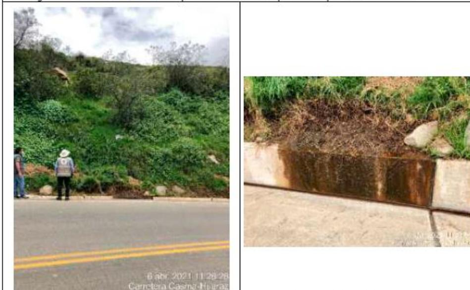
Fotografías N° 16 y 17: Vistas fotográficas de Zona 1 de descarga de lixiviados, hacia el dren pluvial de la carretera que transita por la infraestructura de disposición final.
