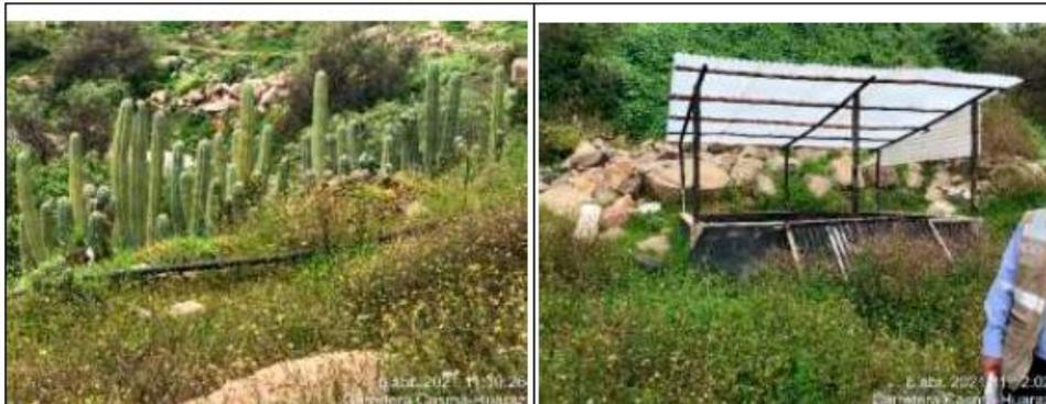
Fotografías N° 14 y 15: Vistas fotográficas donde se advierte la ausencia de canales filtrantes de piedras, y que los lixiviados son conducidos mediante mangueras de pvc. Asimismo, se observó la presencia de la poza de almacenamiento de lixiviados; no obstante, estos no son derivados a dicha poza, sino por el contrario son descargados en dos zonas hacia el dren pluvial de la carretera que transita por la infraestructura.
