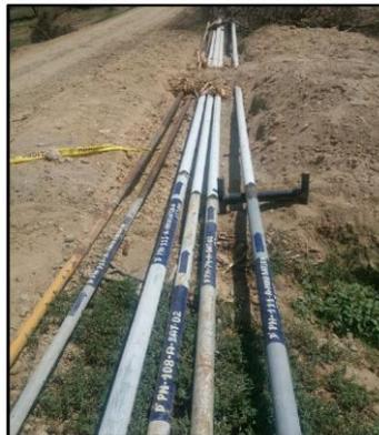
Dentro de la descripción de los trabajos realizados se listó: i) la limpieza mecánica, ii) la inspección visual, iii) la medición de espesores y iv) la aplicación de revestimiento tricapa (cinta shaic).
