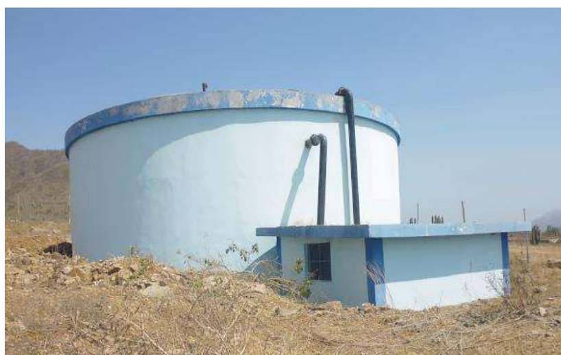
Gráfico VIII.29: Reservoirio de agua de Oyotún sin recepción de obras
