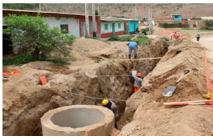
Gráfico VIII.28: Obra de agua y alcantarillado las Delicias
