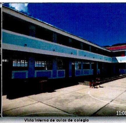
Vista interna de aulas de colegio
