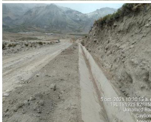
Fotografía N° 13: Vista en donde se señala otro tramo del canal de derivación de agua de no contacto que se encuentra colmatado con material de desprendido del entorno.
