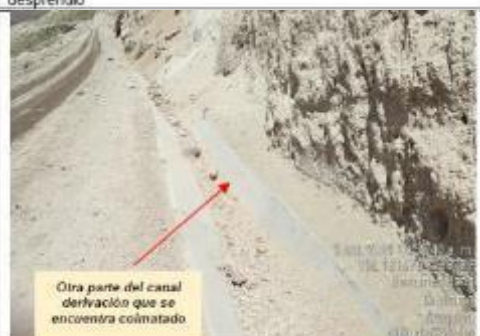
Fotografía N° 13: Vista en donde se señala otro tramo del canal de derivación de agua de no contacto que se encuentra colmatado con material de desprendido del entorno.
