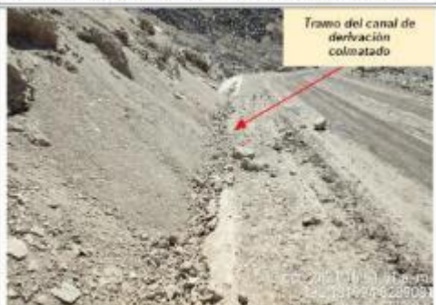
Fotografía N° 12: Se observa que el tramo del canal de derivación de agua de no contacto que se encuentra colmatado con el material desprendido.
