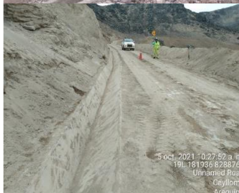
Fotografía N° 12: Se observa que el tramo del canal de derivación de agua de no contacto que se encuentra colmatado con el material desprendido.
