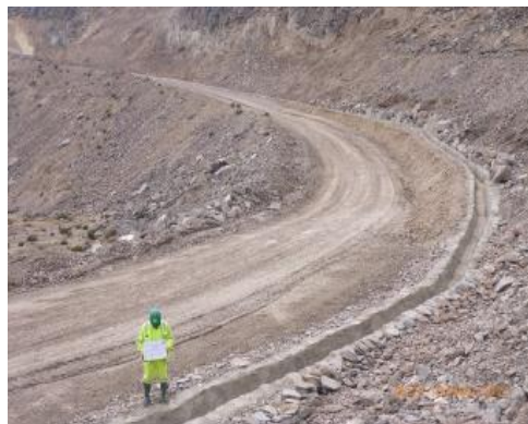
Fotografía N° 11: Vista en donde se señala otro tramo del canal de derivación de agua de no contacto que se encuentra destruido.
