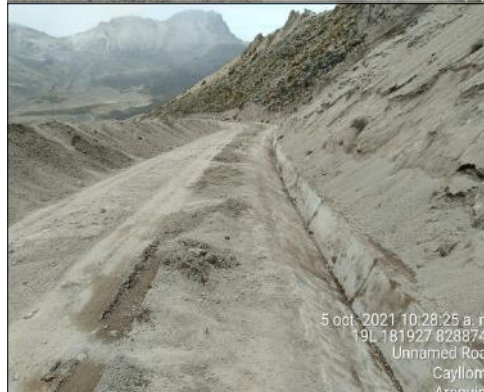
Fotografía N° 14: Se observa que el material acumulado proviene de al aldera del cerro.
