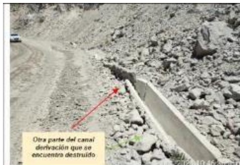
Fotografía N° 11: Vista en donde se señala otro tramo del canal de derivación de agua de no contacto que se encuentra destruido.
