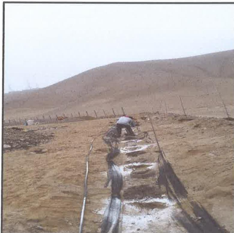
*FOTO N° 6: VISTA DE TRAZO Y REPLANTEO DE TERRENO EN EJE E,F,G,H,I Y A*
