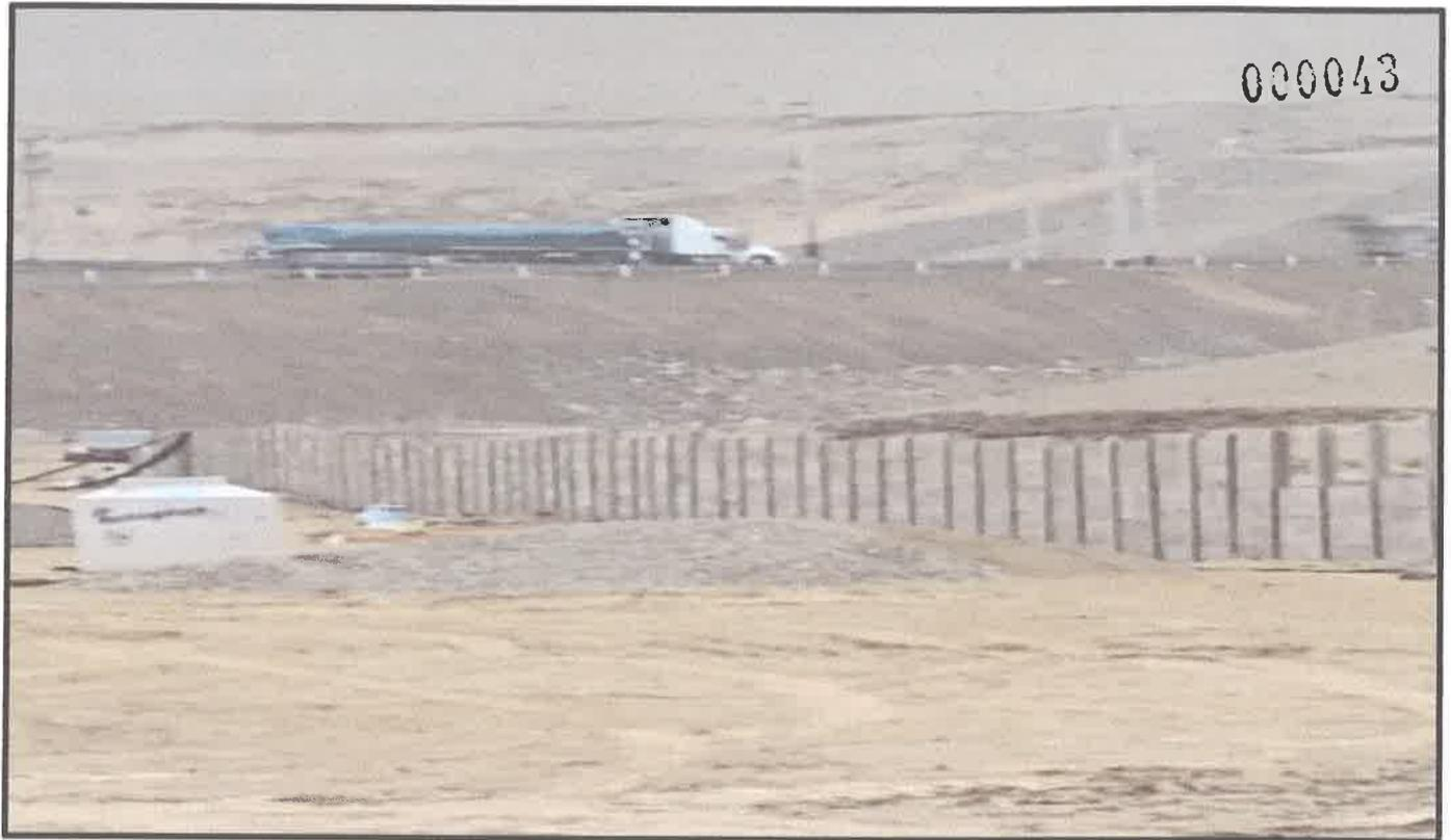
*FOTO N°13: INSTALACIÓN DE PANELES DE CONCRETO PARA CERCO PERIMÉTRICO EN LOS EJES H Y I*
