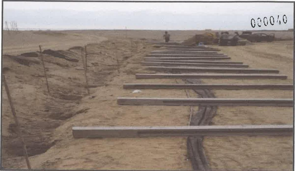
FOTO N° 7 EXCAVACIÓN DE ZANJA EN TERRENO Y COLOCACIÓN DE POSTES EN POSICIÓN
