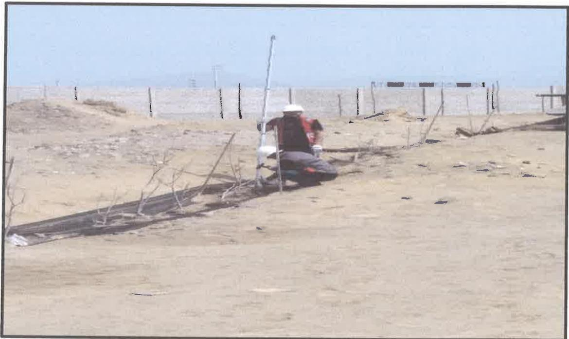
*FOTO N° 03: VISTA DE TRAZO Y REPLANTEO DE TERRENO EN EJE E,F,G,H,I Y A*
