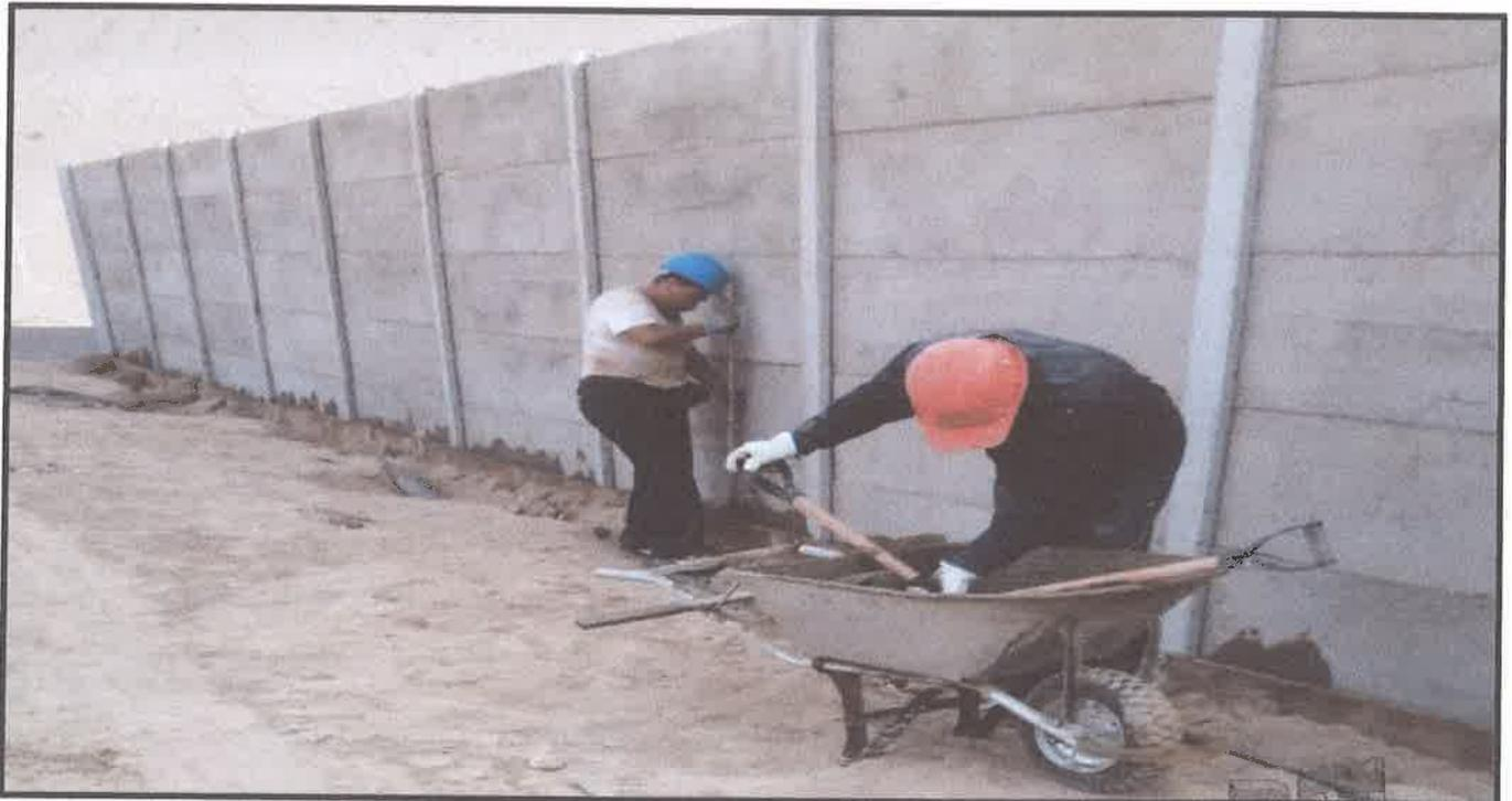
FOTO N° 010: ENCOFRADO DE CIMENTACIÓN CORRID: 1:10 CEMENTO HORMIGÓN 30% PIEDRA
