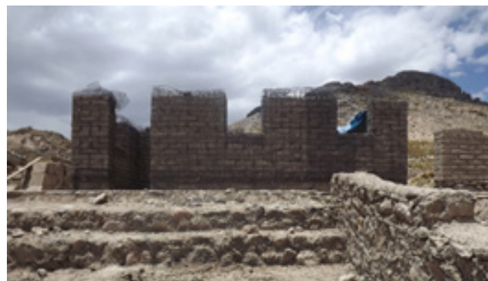
Fig.7 Muros de adobe envueltos con geomalla
