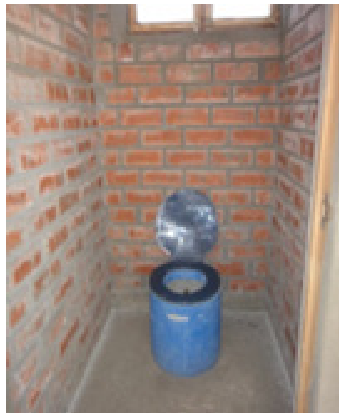
Fig.12 Núcleo sanitario de cocina y cubeta mejorada.
