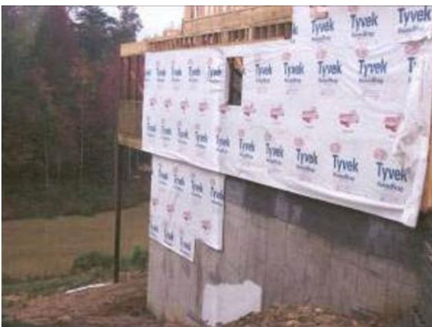
**Figura 13.** Vista de una de las casas que utilizó la arena de Eureka como relleno de cimientos. El sitio de construcción fue excavado hasta alcanzar un suelo estable, luego la arena de fundición se utilizó como relleno para que los cimientos tengan el grado necesario
