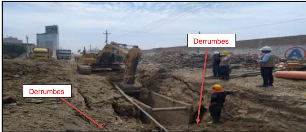
Imagen N° 01.- Se evidencia la inestabilidad del suelo en redes de la Av. Lora y Lora correspondientes al Colector Ingenieros II.
