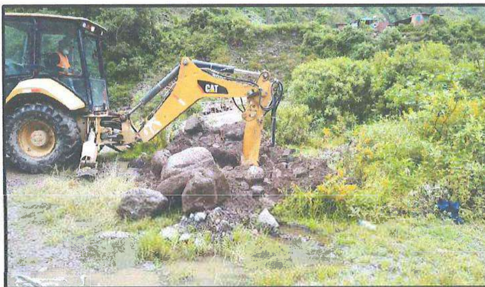
Ilustración 8: Excavación de la calicata para prueba de percolación e infiltración.
