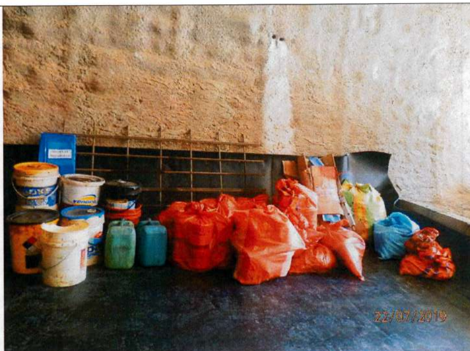
Fotografía N° 15: vista del interior de una de la berma perimétrica, en las cuales se observa la impermeabilización con geomembrana. Asimismo, se señala de amarillo las hojas MSDS en las cuales se indica la peligrosidad de los residuos almacenados, así como el procedimiento a seguir en caso de incidentes.
