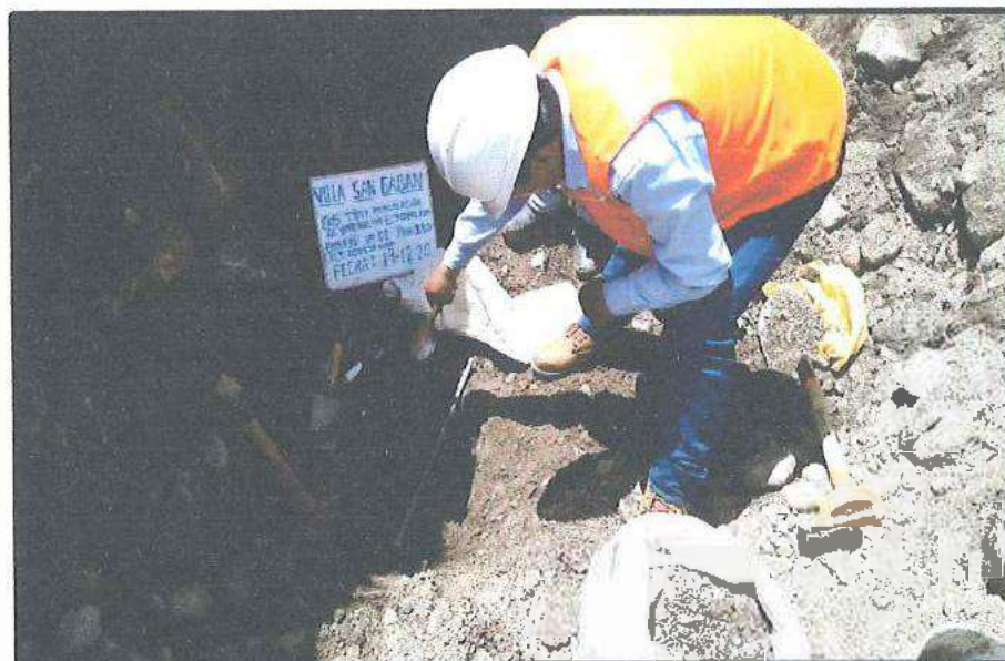
Ilustración 3: Colocación de arena clasificada para el hoyo.
