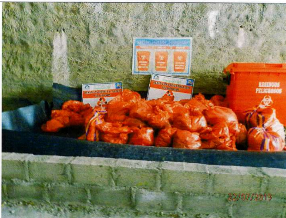
Fotografía N° 17: vista del interior de la segunda berma perimétrica, también impermeabilizada con geomembrana. En esta zona se almacenan residuos peligrosos hospitalarios.
