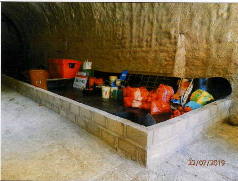
Fotografía N° 14: Vista de las áreas de almacenamiento de residuos peligrosos, las cuales se encuentran al interior de una berma de contención impermeabilizadas con geomembras, las cuales no presentan grietas ni rajaduras.
