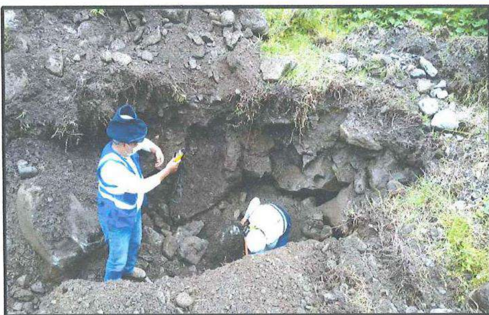
Ilustración 10: Preparando la calicata para prueba de percolación e infiltración.
