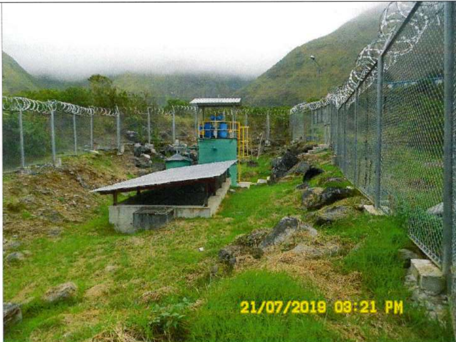
Fotografía N° 11: vista de la Planta de tratamiento de Aguas Residuales Domésticas, la cual trata todas las aguas residuales generadas en la "Villa de Residentes San Gabán II" para que posteriormente el agua clarificada (tratada) sea infiltrada al subsuelo a través de una cámara de percolación.
