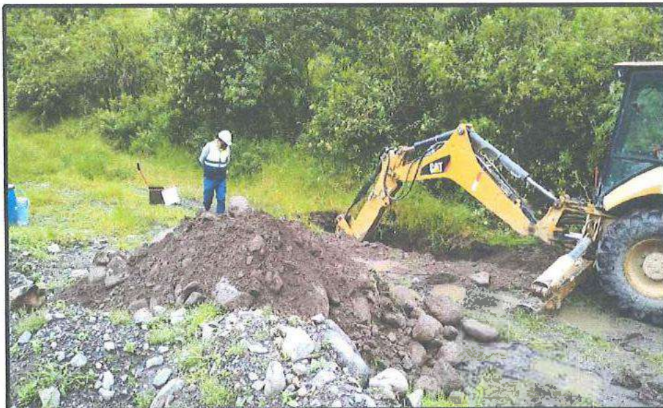
Ilustración 7: Excavación de calicata para prueba de percolación e infiltración.
