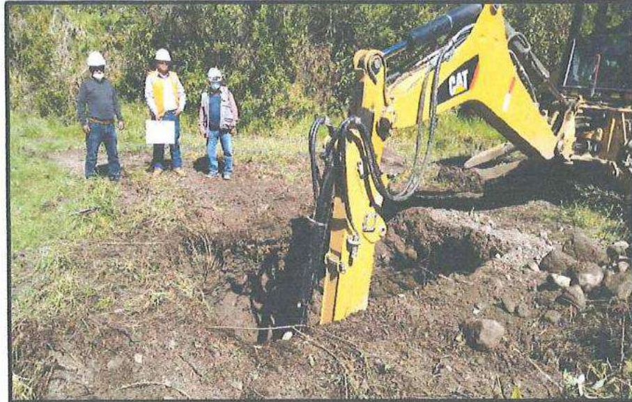
Ilustración 1: Excavación de calicata para prueba de percolación e infiltración
