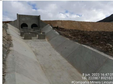
Figura 33: Vista de la alcantarilla y dados de disposición del tramo 6.
