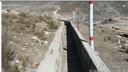
Figura 1: Inicio del canal de coronación Oeste
