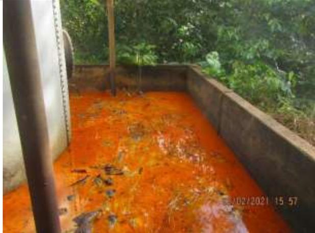
Fecha de registro: 02.02.2021 a las 15:57 horas, se verifica hidrocarburos en el interior del área estanca del tanque diésel
