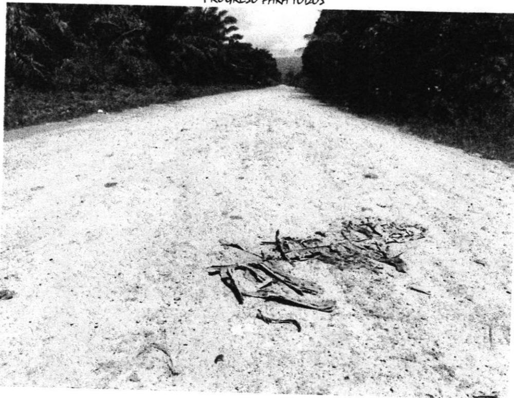
*Ilustración 3: PRESENCIA DE MATERIAL SUELTO Y PIEDRAS.*
