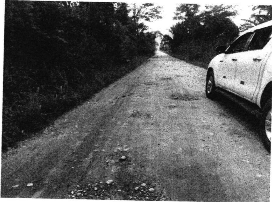
*Ilustración 2: VISTA DE LA CONDICION ACTUAL DE LA VIA, PERDIDA DE MATERIAL AFIRMADO, SUPERFICIE DE RODADURA EROSIONADA.*
