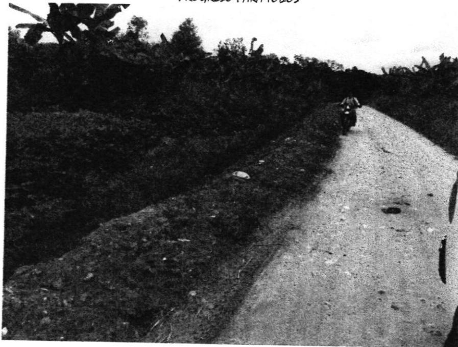
*Ilustración 7: VISTA DE LA CONDICION ACTUAL DE LA VIA EN LA PROGRESIVA 11+000. PRESENCIA DE MATERIAL SUELTO, SUPERFICIE SIN MATERIAL AFIRMADO.*
