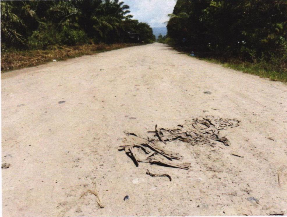
*Ilustración 3: PRESENCIA DE MATERIAL SUELTO Y PIEDRAS.*
