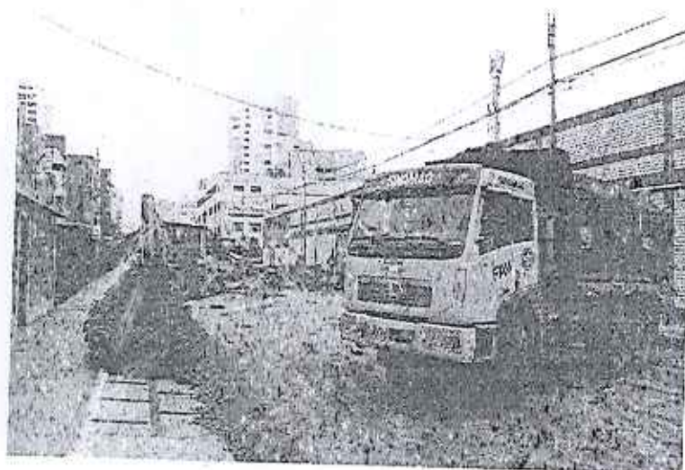
Eliminación de material demojado.
