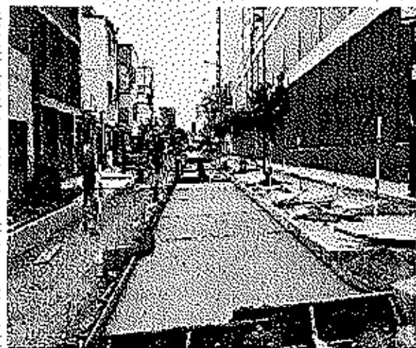
Vaciado de la pista lado derecho
