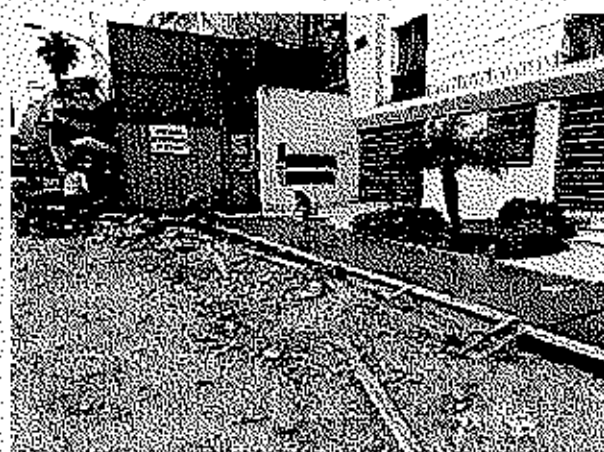
vaciado de vereda lado derecho
