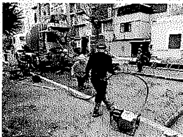
Vaciado de pista carril lado derecho
