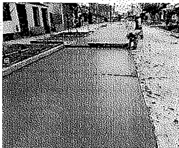
Vaciado de pista lado izquierdo
