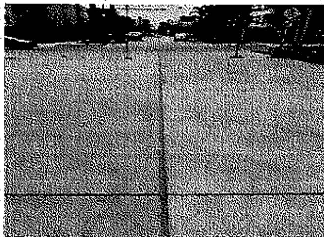
Vista del relleno de las juntas con emulsión asfáltica de las cuadras 2 y 3 respectivamente
