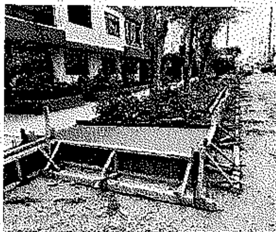
Encofrado y vaciado de sardineles lado izquierdo
