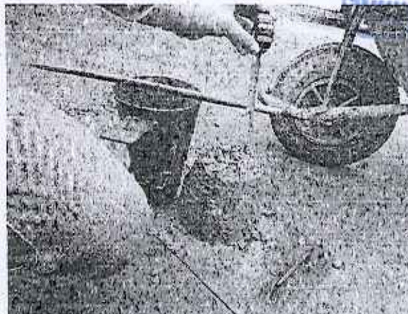
Control de calidad del concreto
