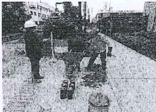
Extracción de testigos de concreto
