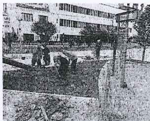
Vista de los vaciados de pista del carril izquierdo
