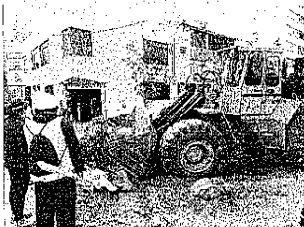
Ramoción de escombros de la vía cuadra 12
