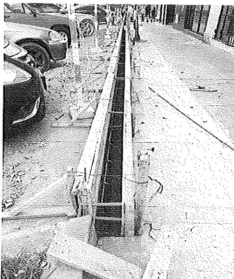
Habilitación / armado de acero de refuerzo  $f'_{y} = 4200\text{kg/cm}^2$  y Encofrado para sardinej peraltado (0.15 X 0.40m)
