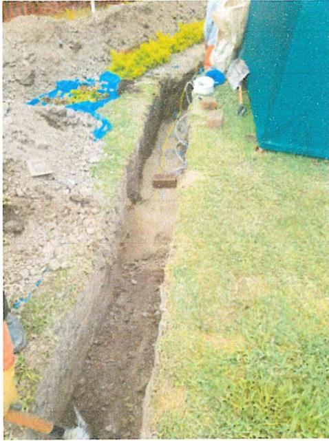
Foto.03 – SE VERIFICA INSTALACION DE CABLES EN EL CIERCUITO 2 CON LA COLOCACION DE CAMA DE ARENA
