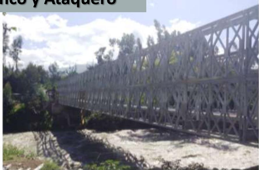
**El IVP-Carhuaz, actualmente viene gestionando puentes modulares Tipo ACROW del Programa Puentes Modulares de PROVIAS DESCENTRALIZADO.**
