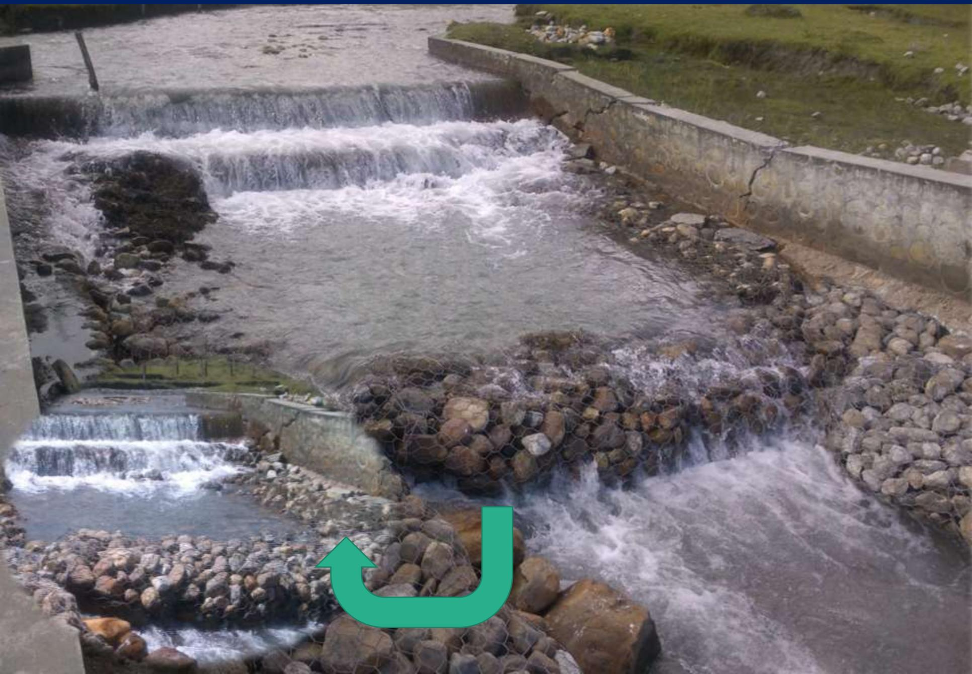
**LINEA DE CONDUCCION SIN PROTECCION PRODUCTO DE LOS DESLIZAMIENTOS**
