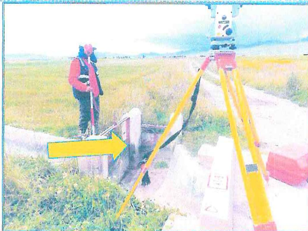
IMAGEN 10: SE OBSERVA EL LEVANTAMIENTO TOPOGRAFICO CON EL EQUIPO ESTACION TS06 LEICA
