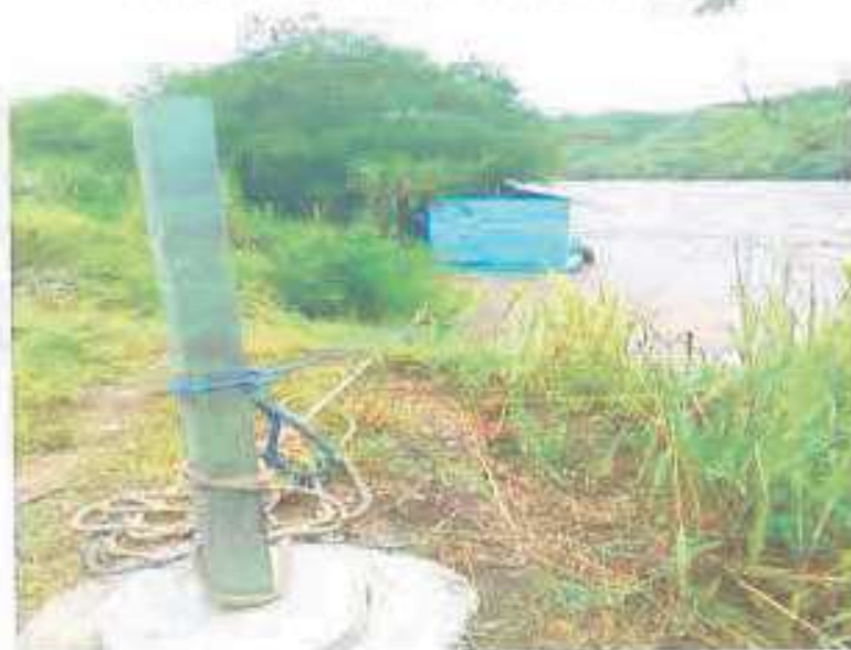
Imagen N° 65: Captación PTAP Río Huallaga
