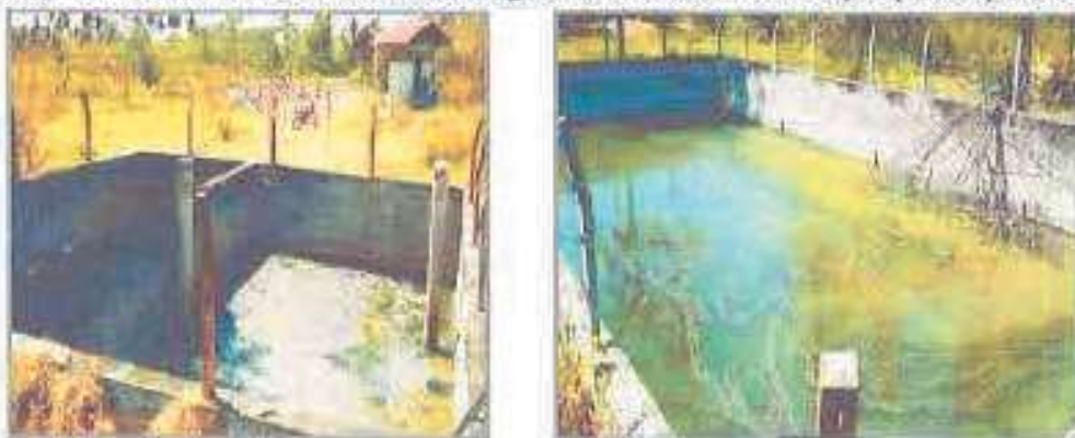
Imagen N° 90: Planta de tratamiento de aguas residuales PTAR Caspizapa colapsada.
