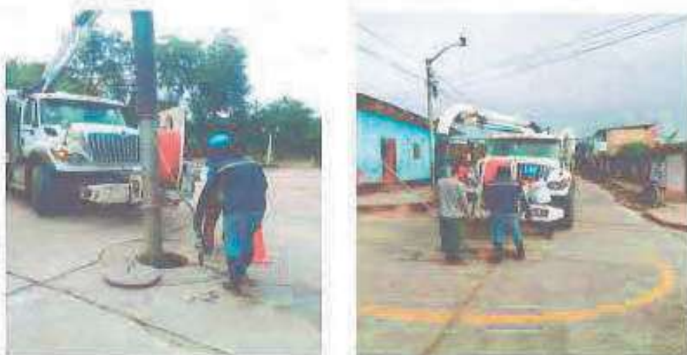
Imagen N° 89: Mantenimiento de los Buzones con el Hidrojet
