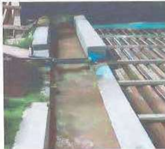
Imagen N° 76: Canal de mezcla rápida
