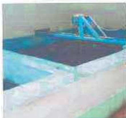
Imagen N° 75: Tanque de solución existente y dosificadores
