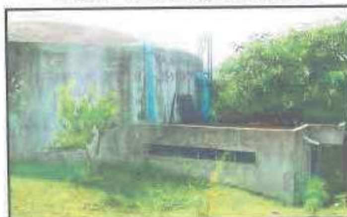
Imagen N° 61: Vista del reservorio de 500 m 3
