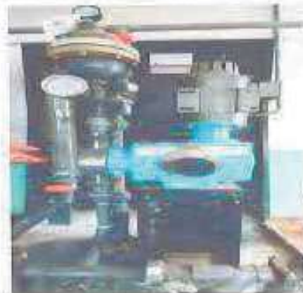
Imagen N° 75: Tanque de solución existente y dosificadores
