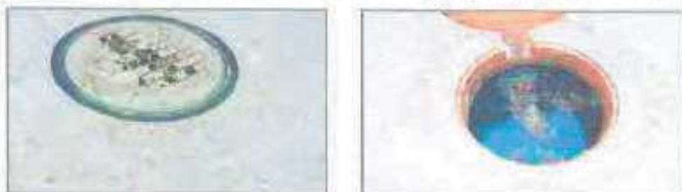
Imagen N° 88: Buzones colapsados por atoro de colector e ingreso del drenaje pluvial.
