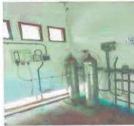
Imagen N° 81: Sistema de cloración por goteo y sistema de cloro gas sin funcionamiento
