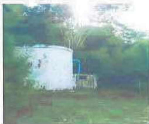
Imagen N° 83: Reservorio de 90 m 3 y caseta de válvulas.
