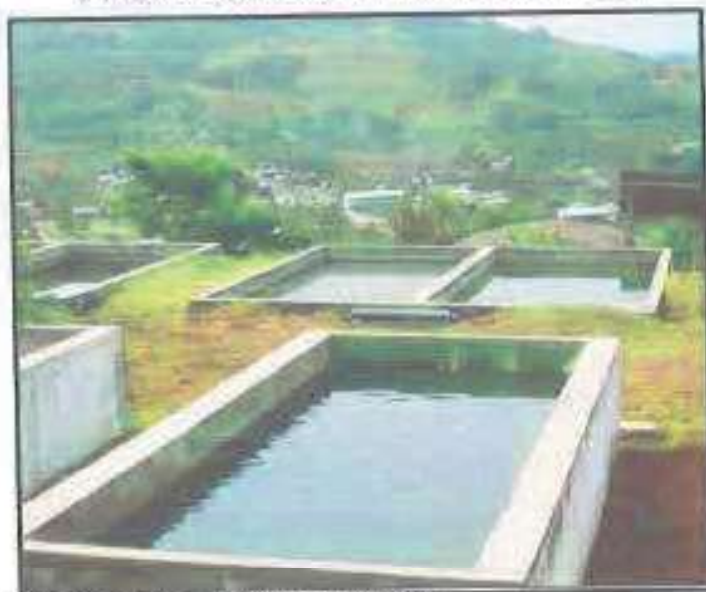
Imagen N° 59: Vista de la PTAP San José de Sisa
