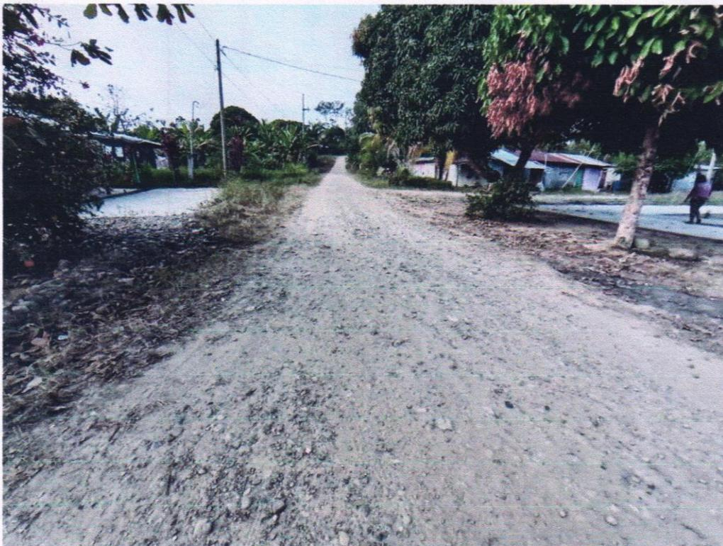
*Ilustración 10: VIA QUE CONDUCE A LA LOCALIDAD DE ALTO GUAYNABE, PRESENCIA DE EROSION DE MATERIAL AFIRMADO, PRESENCIA DE MALEZA A AMBOS MARGENES DE LA VIA.*
