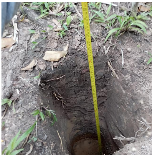
Verificación de dimensiones de calicatas
