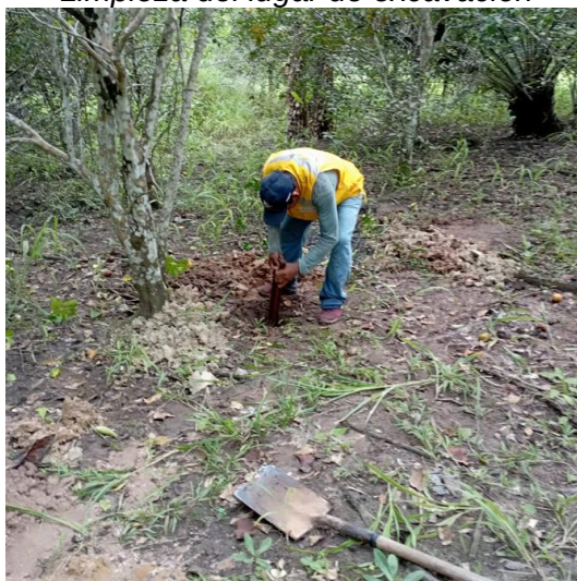
Proceso de excavación de calicatas para prueba de percolación
