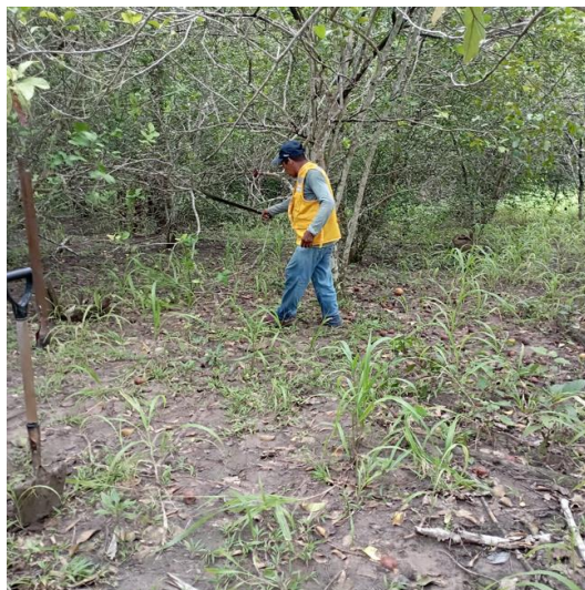
Limpieza del lugar de excavación
