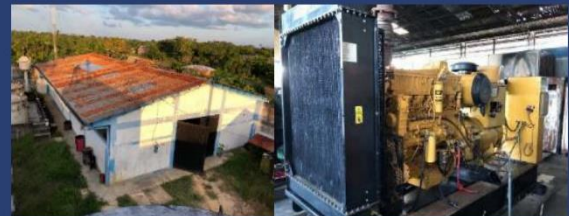
Planta Térmica de El Estrecho
