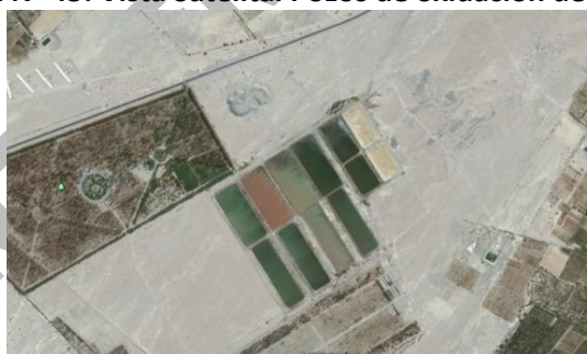
Imagen N° 45: Vista Satelital Pozos de oxidación de Magollo
