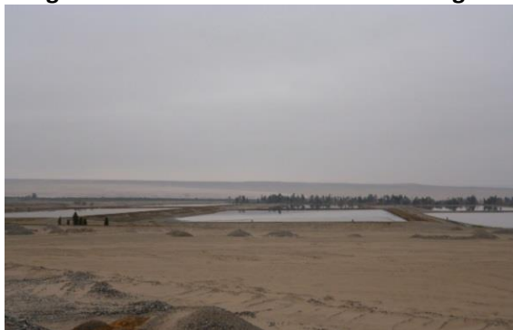
Imagen N° 44: Pozos de oxidación de Magollo
