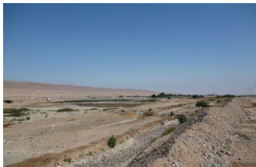
Imagen N° 40: Pozos de oxidación de Viñani
