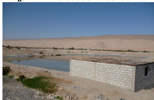
Imagen N° 41: Pozos de oxidación de Viñani
