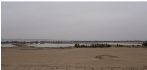
Imagen N° 43: Pozos de oxidación de Magollo
